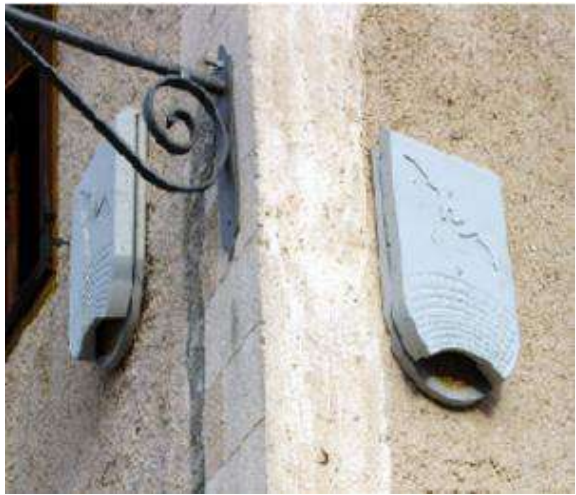
Gîte de façade pour Chauve-souris et exemple de pose
