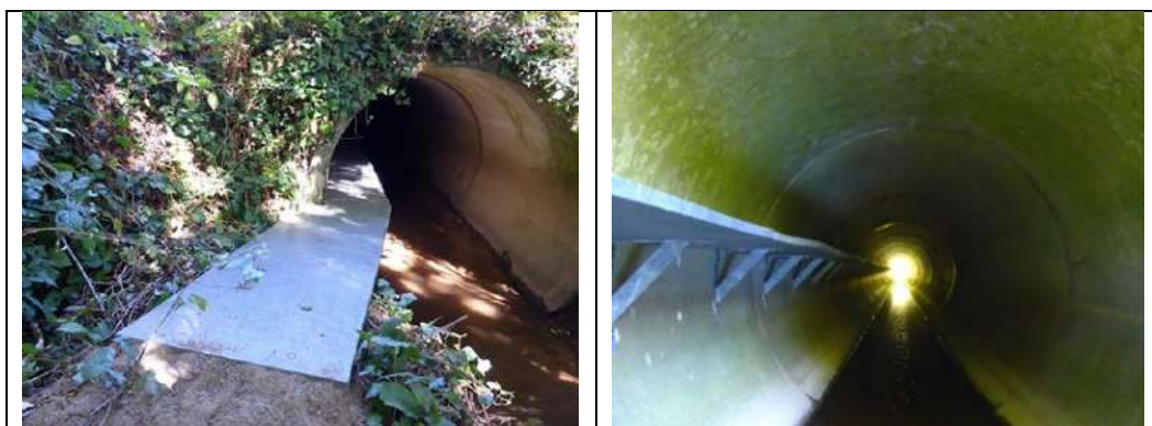
Exemple de banquette en encorbellement - Cerema
