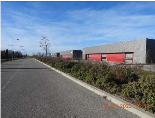
Bâtiments et voiries
