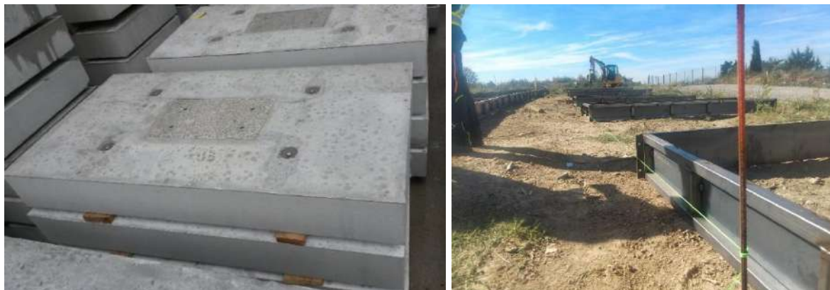
Exemple de fondation fabriquée en série en usine (gauche) et fondation coulée en place (droite)
