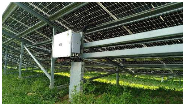
Figure 1: Exemple d'onduleur accroché derrière les tables de modules
