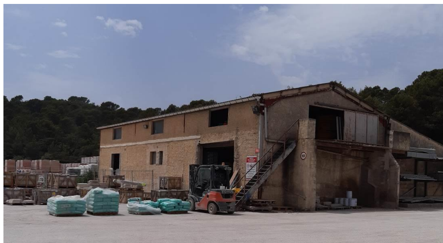
Photo 1 : Hangar de Stockage
