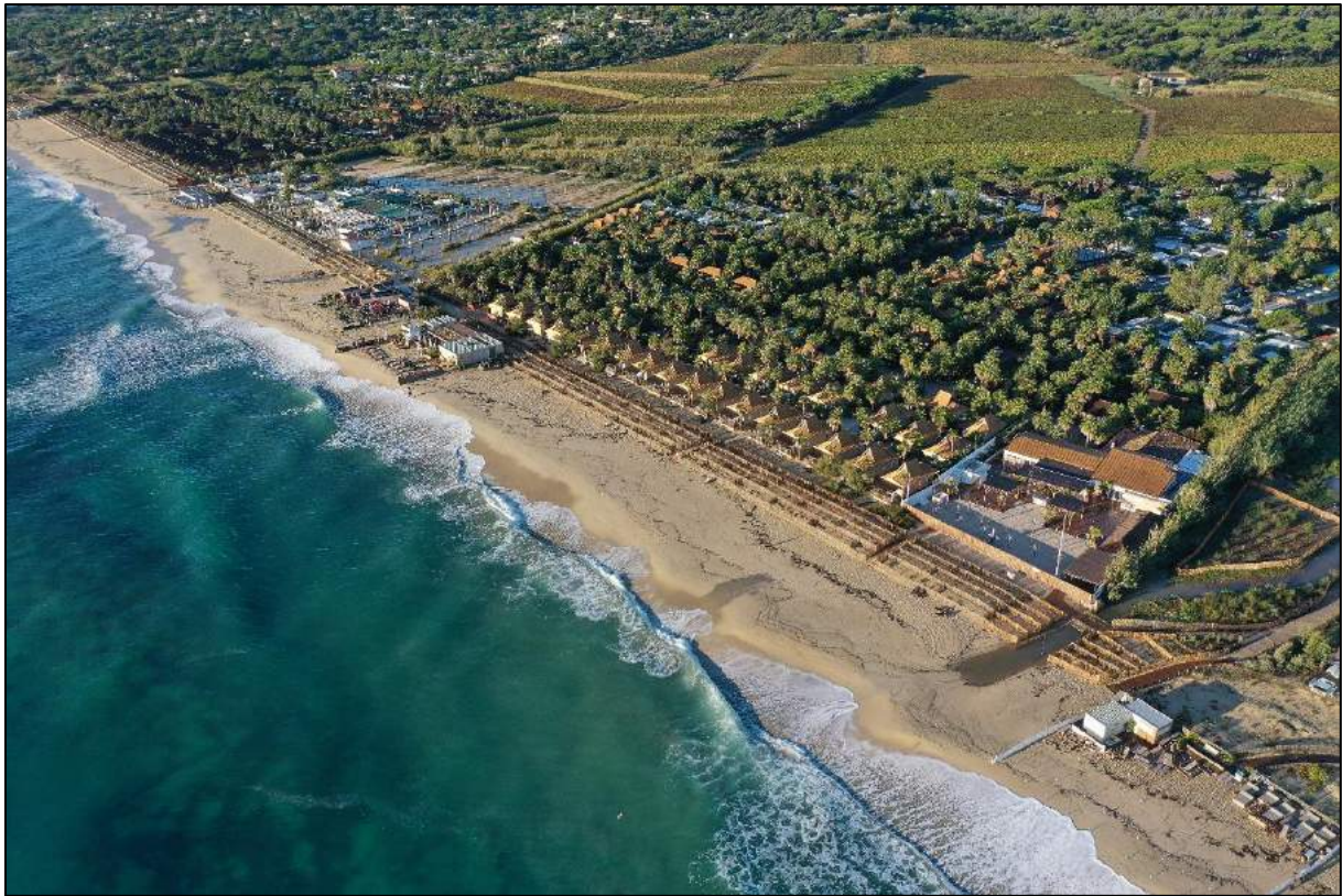
Secteur Camping - Situation après travaux La mise en œuvre de casiers de ganivelles vise à la reconstitution d'un cordon dunaire (Source : Commune de Ramatuelle)
