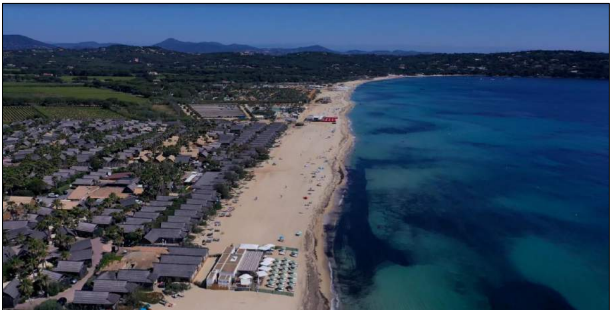
Secteur Camping - Situation avant travaux Absence totale de cordon dunaire (Source : Commune de Ramatuelle)
