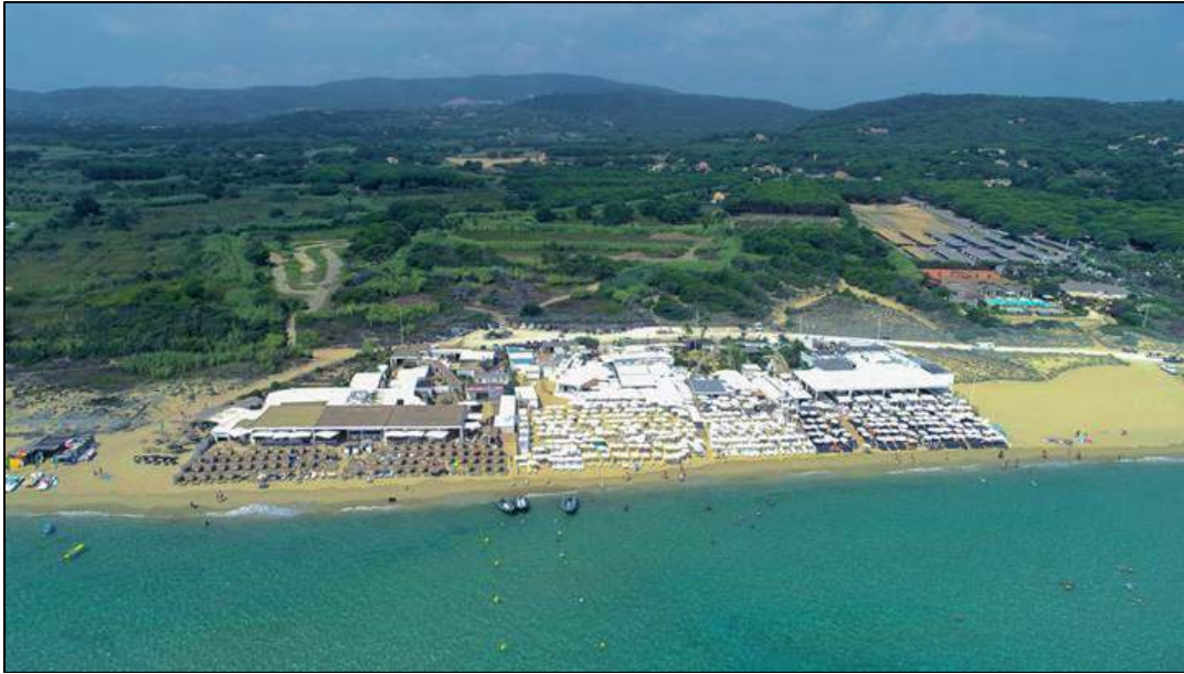
Secteur Epi Sud avant travaux (Source : Commune de Ramatuelle)
