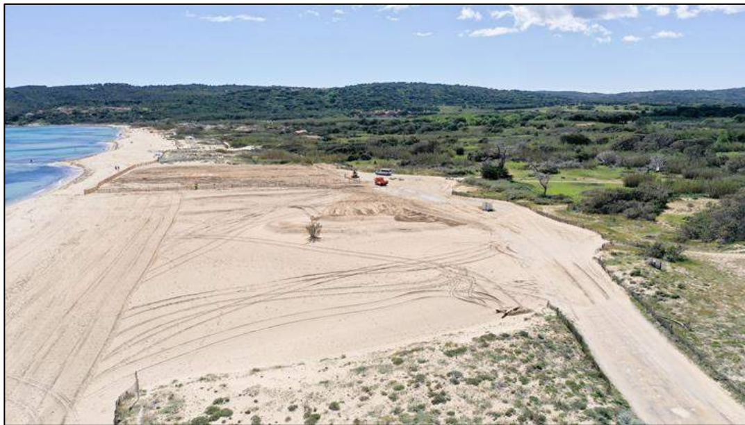
Secteur Epi Sud après démolition des établissements de plage La zone est rétablie à l'état naturel avec reconstitution d'un cordon dunaire (Source : Commune de Ramatuelle)
