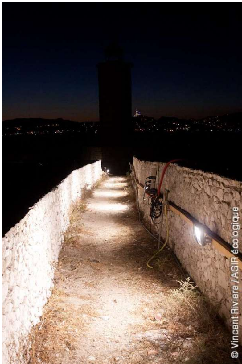
Eclairage du chemin de ronde du parapet secteur 7
