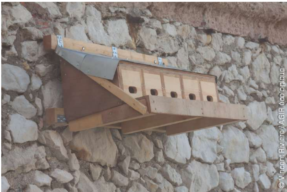
Nichoirs installés sur le rempart, en faveur des Martinets pâles
