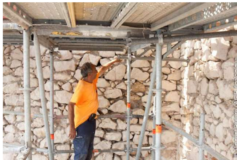
Repérage du nid en compagnie du Chef de chantier.
