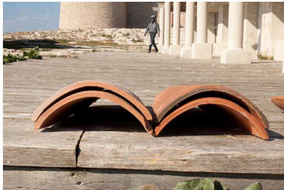
Différence d'espacement entre deux modèles de tuile. A gauche : les tuiles utilisées pour le suivi. A droite, des tuiles standards. L'espacement est trop important entre deux tuiles standard.
