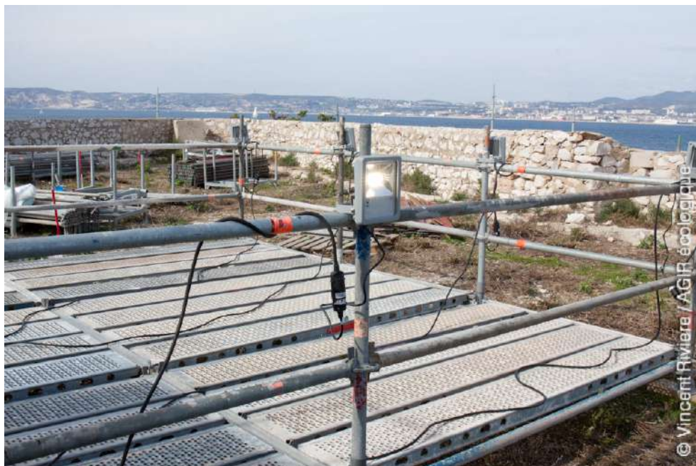
Installation des éclairages sur la structure dédiée
