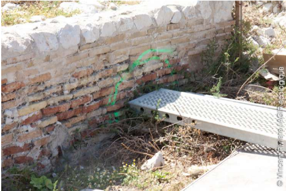
Stockage des éléments d'échafaudages sur le gîte artificiel pourtant indiqué en vert.
