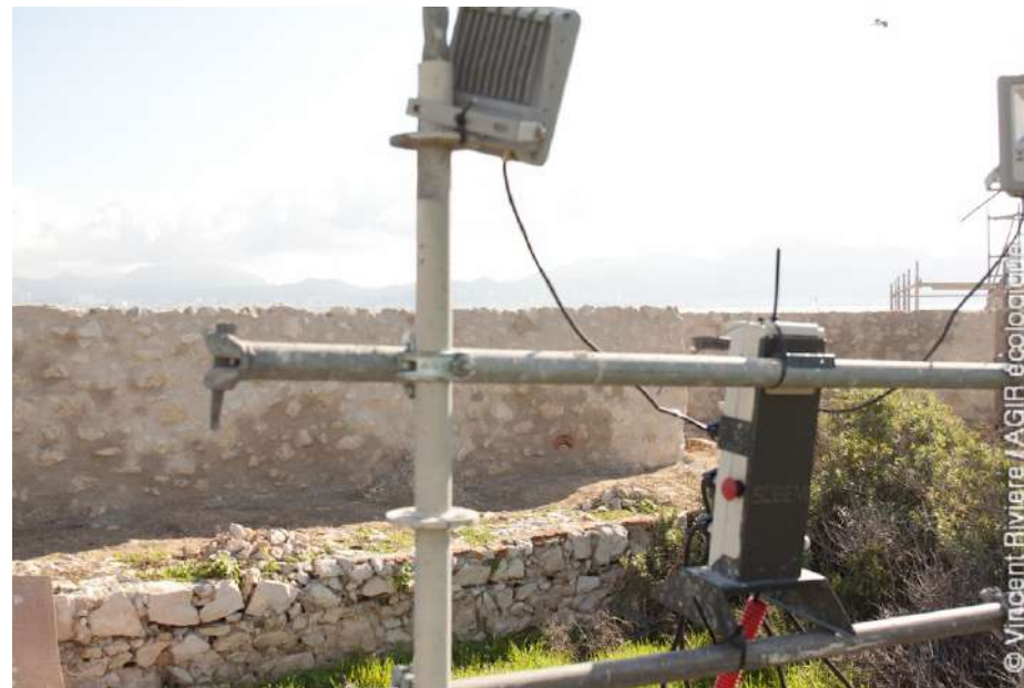
Eclairage installé sur le secteur 4
