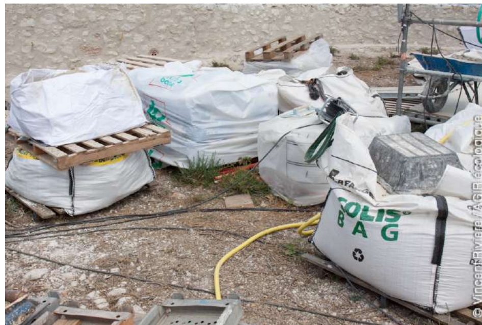
Le stockage des matériaux respecte les préconisations – tous les matériaux sont entreposés sur des palettes
