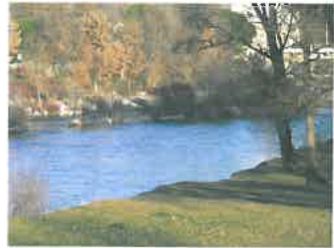
Vue aval pont du 15 août – Parc et Verdon
