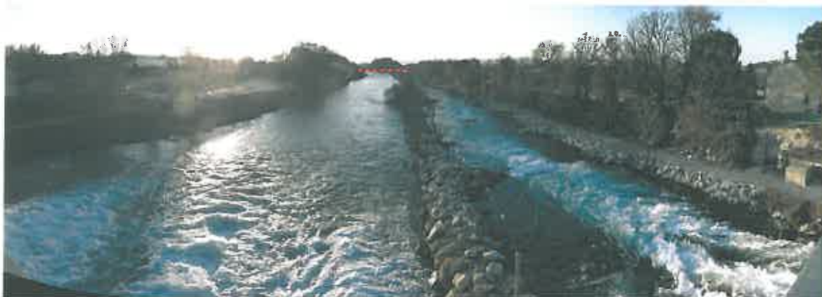
Vue du pont du 15 août
