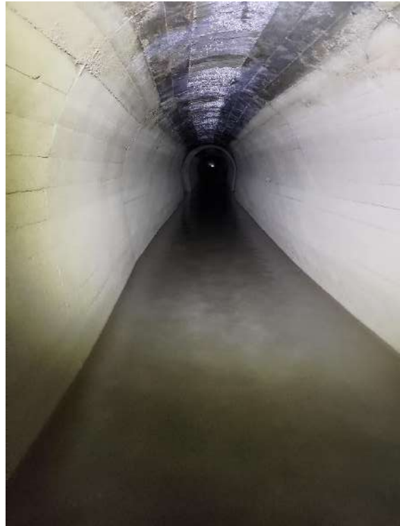
Figure 10 Zone bétonnée sans désordre PM 130
