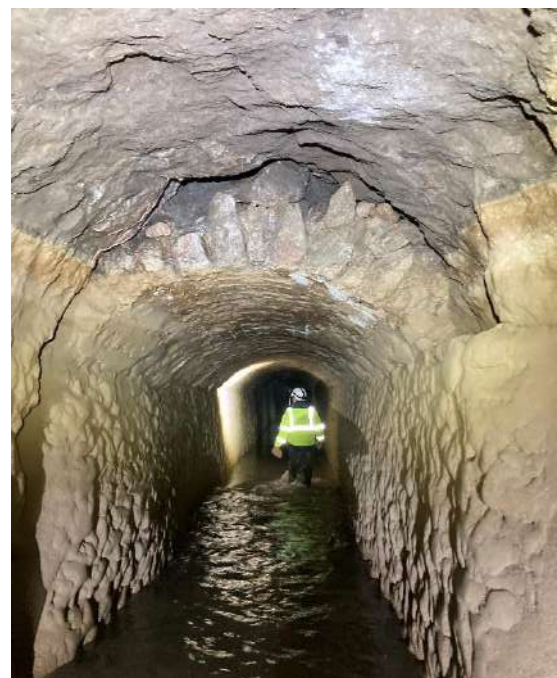
Figure 8 Début section maçonnée PM 600
