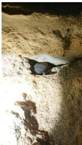
Photo 4 : Exemple de zones à conserver en l'état (micro-gîte)
