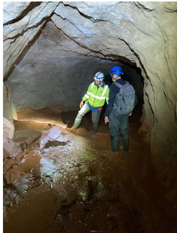
Figure 19 Dépôt argileux PM 950
