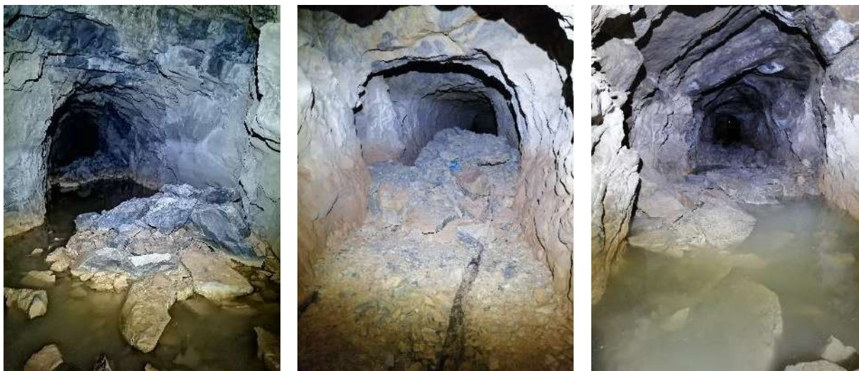
Photos d'écroulements en radier aux PM 1030 – PM 2750 – PM 3400
