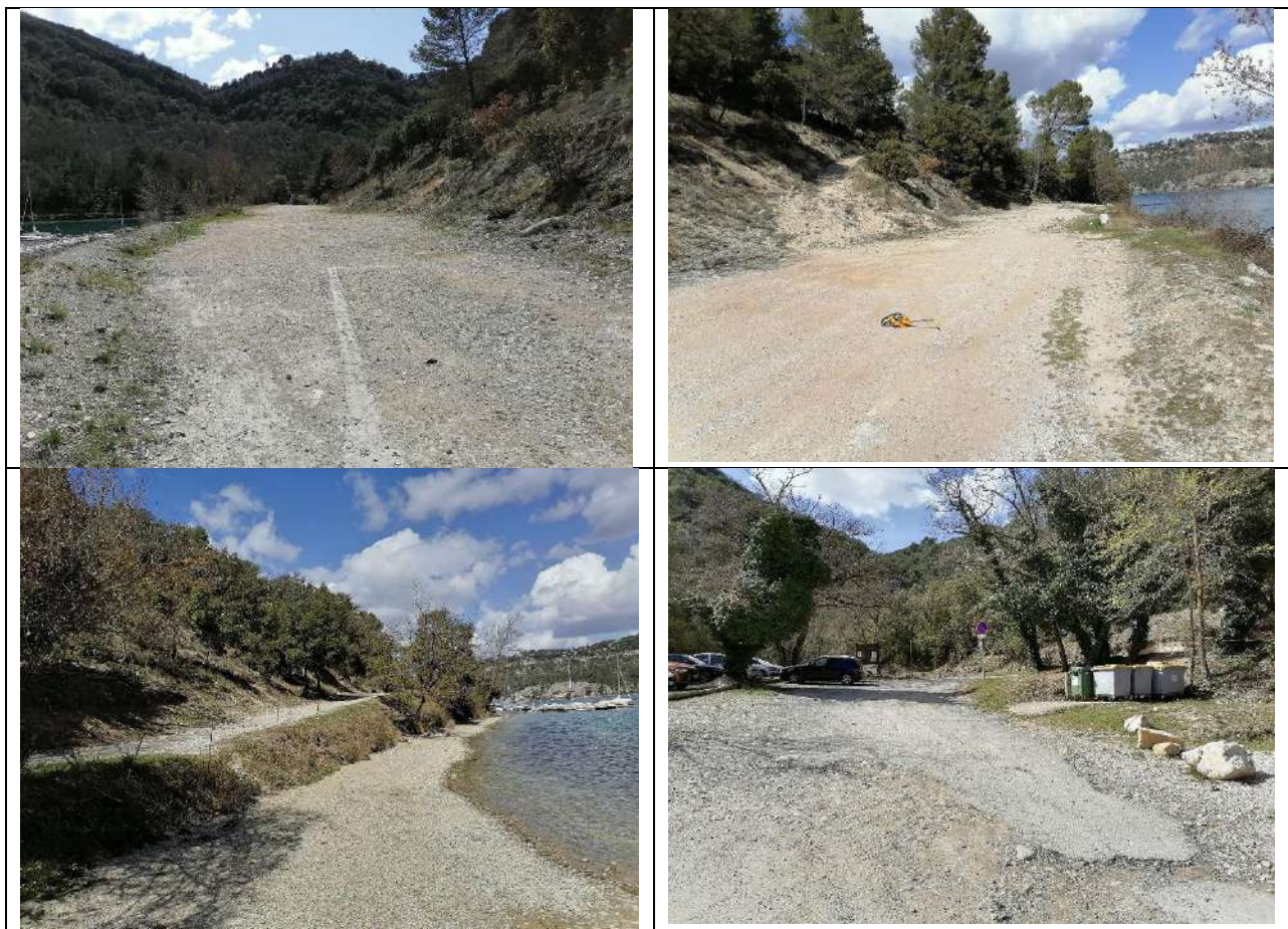
Photos partie amont (dont piste sous laquelle la canalisation va être posée)
