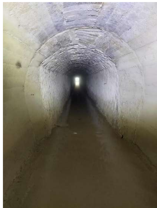
Figure 24 - PM150 passage à section maçonnée
