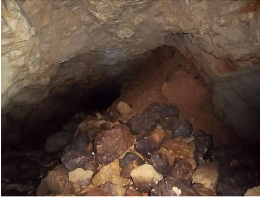
Figure 16 Éboulement au niveau du puits 8 (2012)
