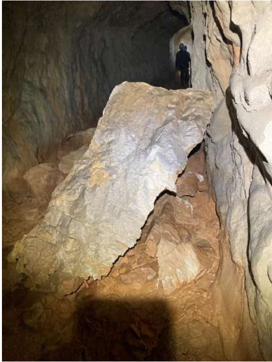
Figure 15 Gros bloc provenant de la voûte PM 2450
