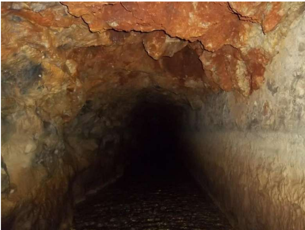
Figure 17 Section en aval du souterrain (2012)
