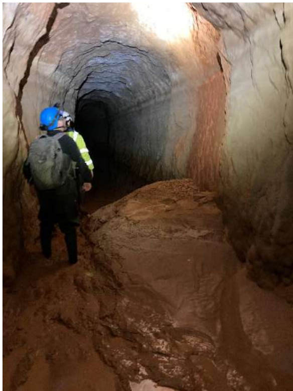
Figure 18 Déport argileux PM 1290
