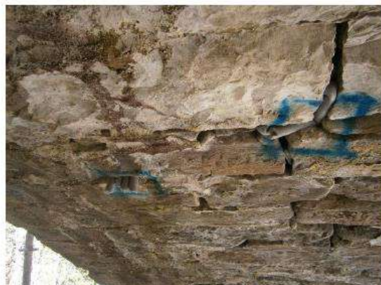
Photo : cavités obturées à la mousse
