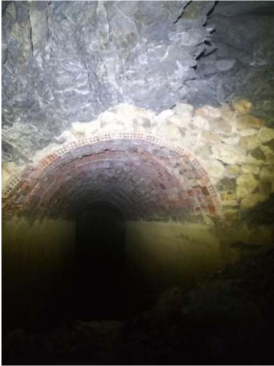
Figure 6 Déformation briques PM 250
