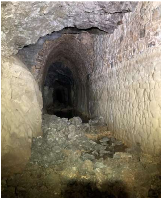
Figure 9 Maçonnerie en piedroit PM 370
