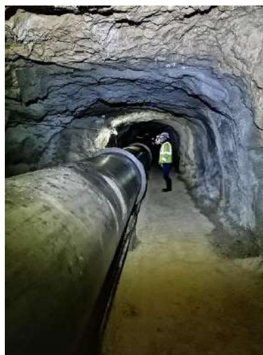
Photo 1 : Exemple de zone traitée au béton projeté (en gris)
