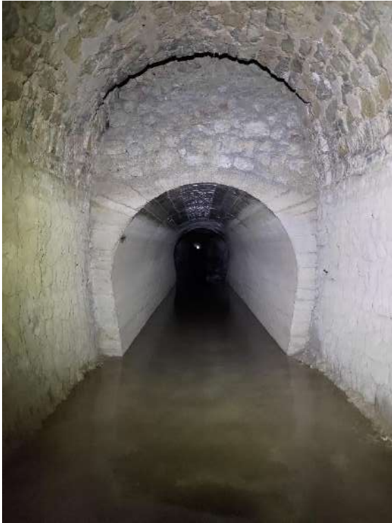
Figure 11 Zone bétonnée PM 300
