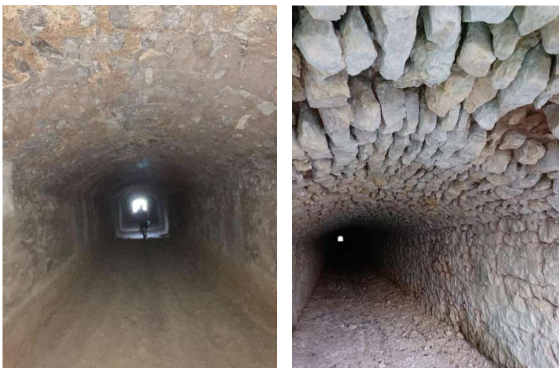
Photos du tunnel des Marlines
