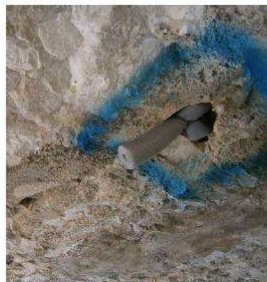
Photo : la gaine qui dépasse permet de retirer le dispositif après projection
