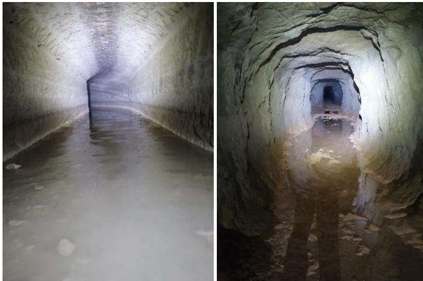
Photos sections types maçonnée (PM 330) et rocher brut (PM 1890)
