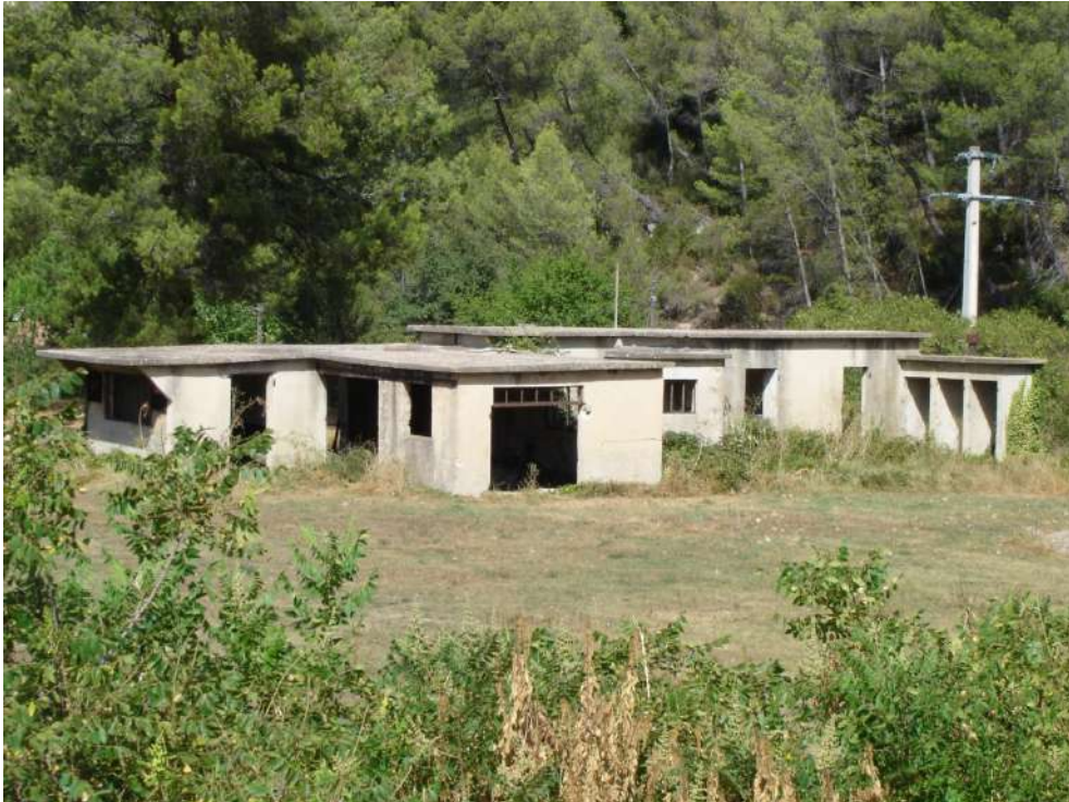
Photo 19 - Lampisterie et locaux techniques de la descenderie Sainte-Berthe.
