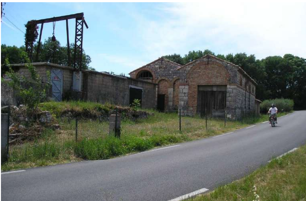
Photo 16 - Chevalement du puits Sainte-Barbe et salle des machines.
