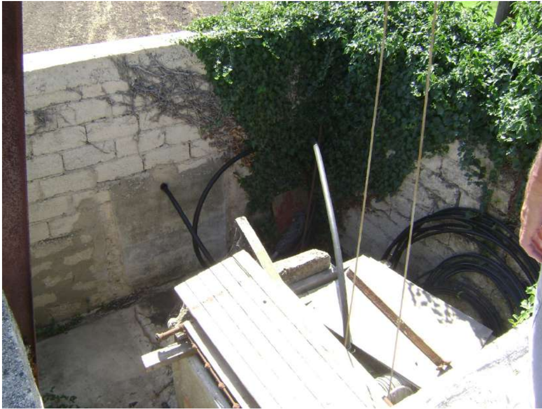
Photo 1 - Puits Sainte-Barbe aménagé en puits pour eau avec mur d'enceinte.
