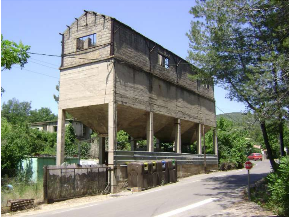
Photo 21 - Trémie de chargement de la descenderie Sainte-Berthe.
