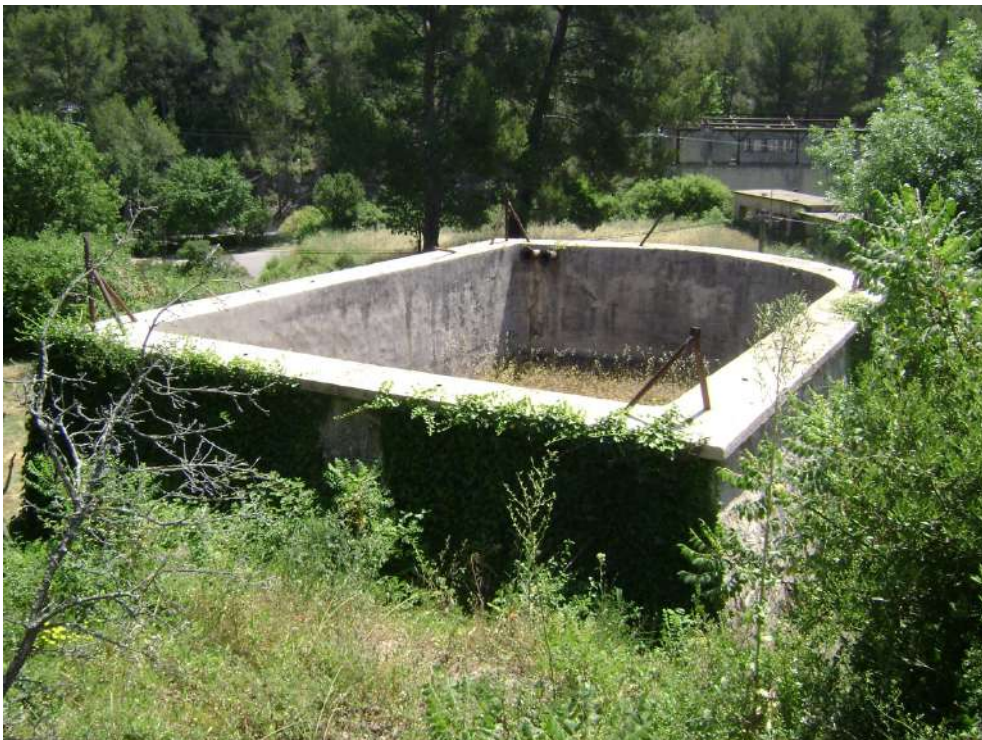
Photo 22 - Bassin de réception des eaux d'exhaure de la descenderie Sainte-Berthe.
