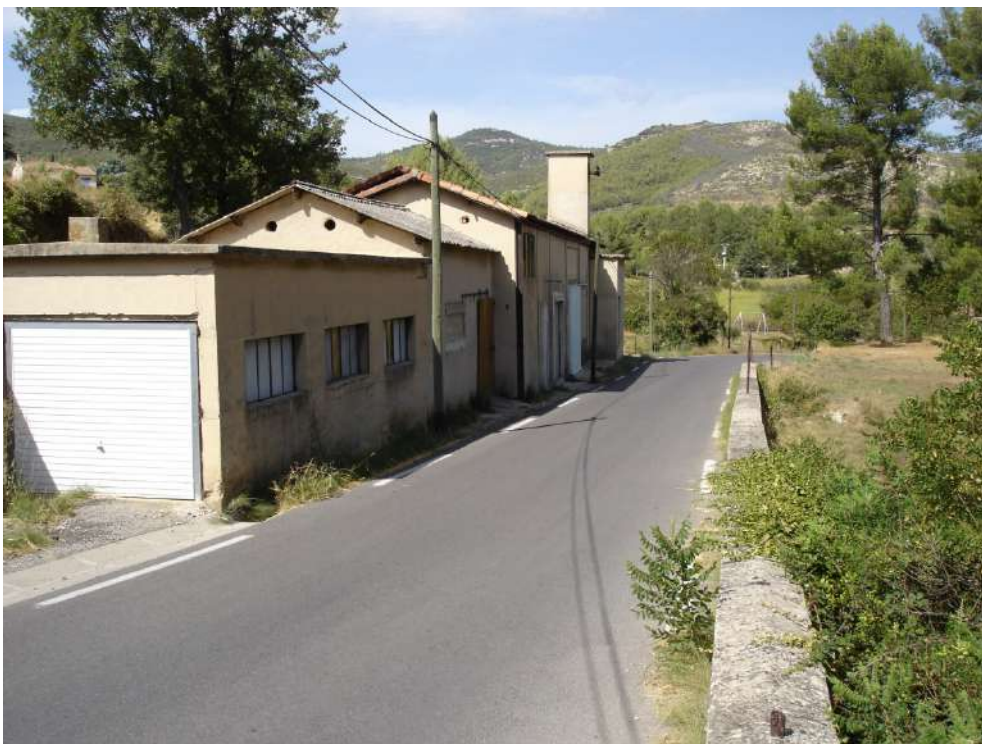
Photo 18 - Locaux techniques de la descenderie Sainte-Berthe.
