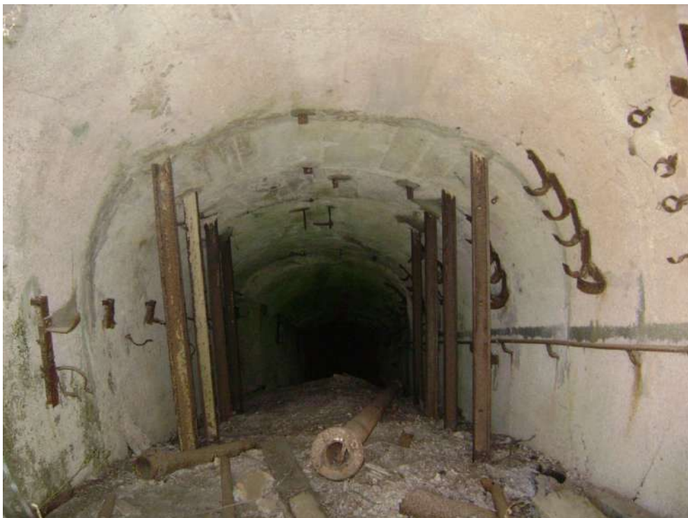
Photo 4 - Descenderie Sainte-Berthe : vue intérieure (à travers la grille).
