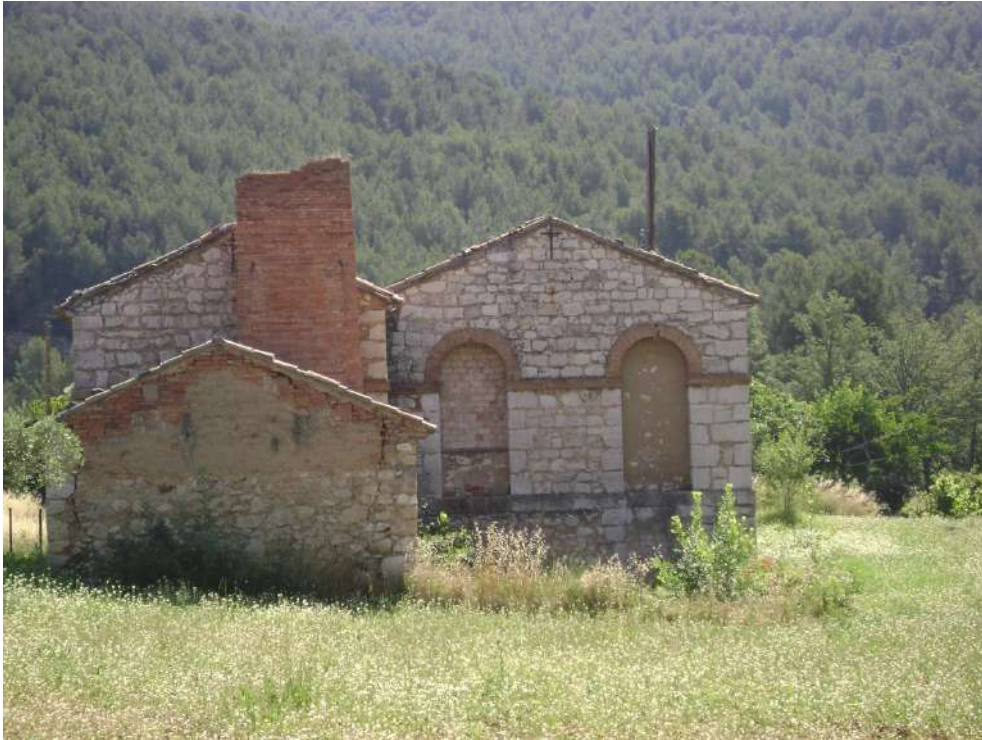
Photo 17 - Base de la cheminée carrée en briques (puits Sainte-Barbe).
