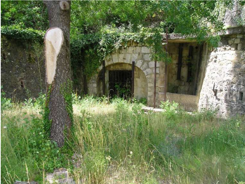
Photo 3 - Descenderie Sainte-Berthe (grille fermée par un cadenas).
