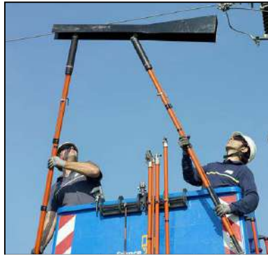
Installation de profilé anti-électrocution
