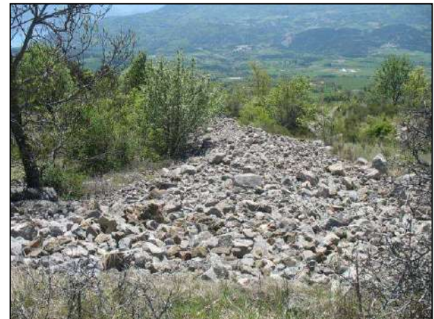
M. DALLIET, 04/05/2011, La Bâtie-Neuve (05)
