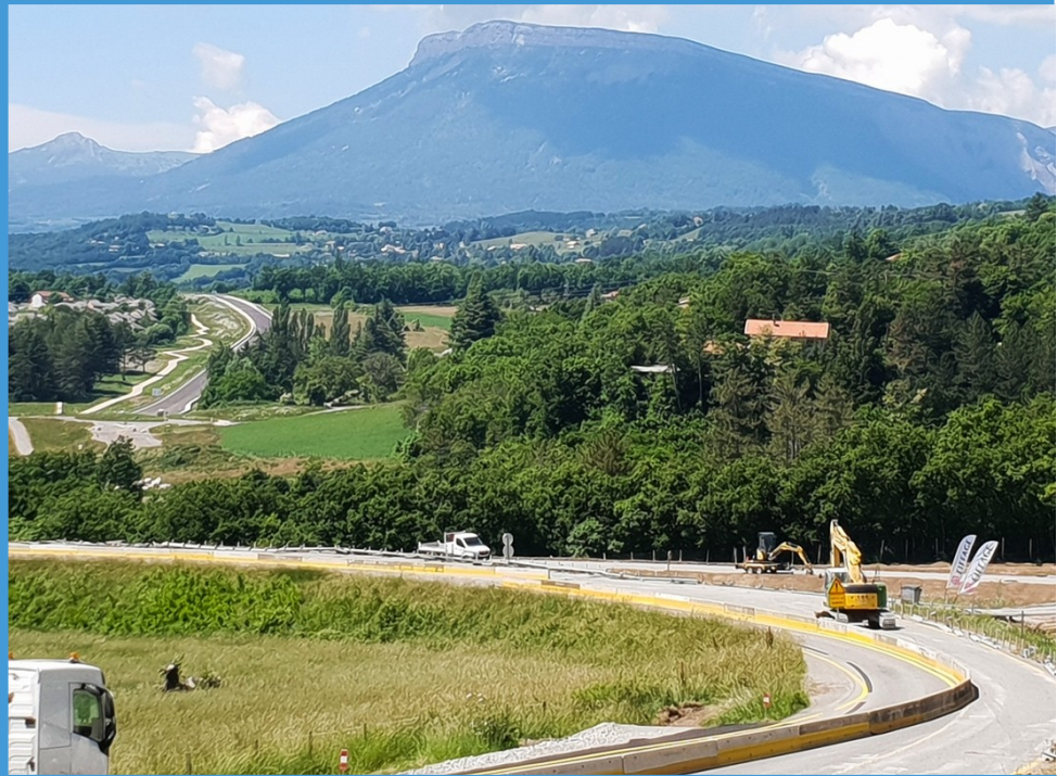
Travaux de la courbe de Varsie avec au second plan la section Sénateur-Aurouzes et la voie verte aménagée Source : DREAL PACA
