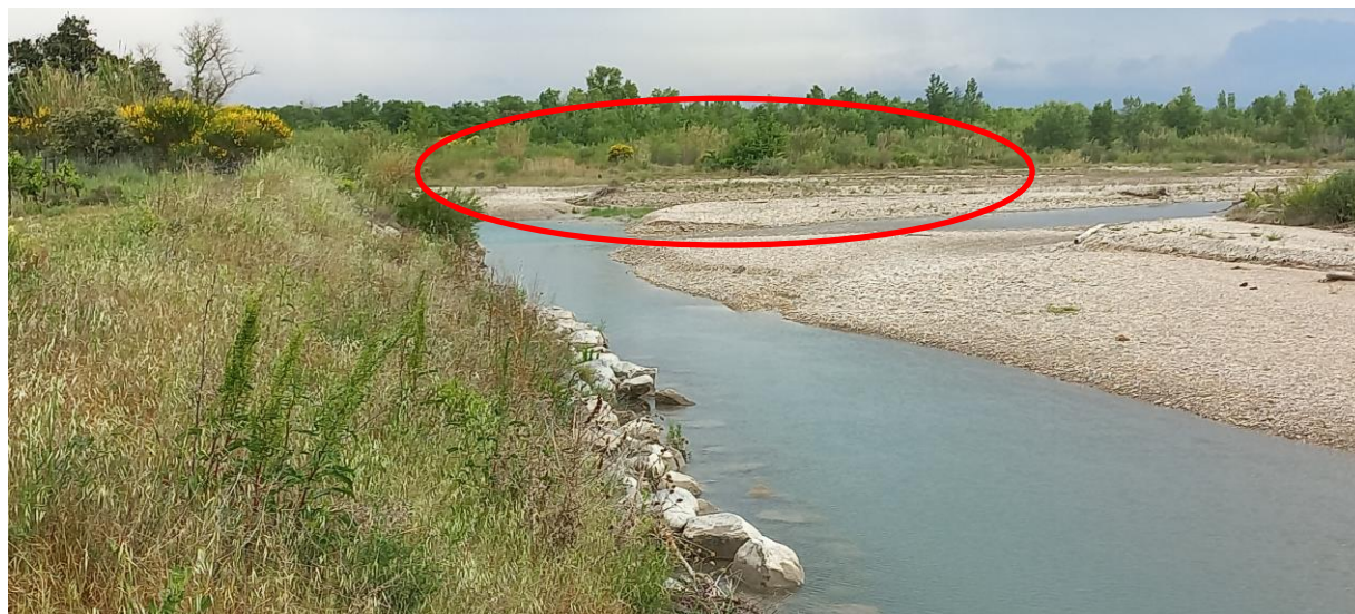
Figure 8 : Vue de la bonne intégration des aménagements de 2010
