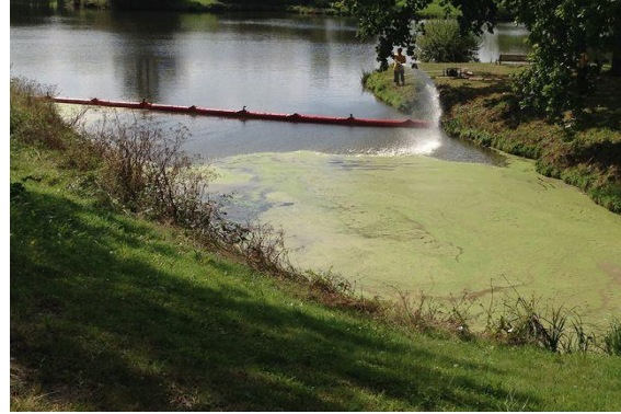
Figure 7 - Exemple des barrages flottants anti-pollution
