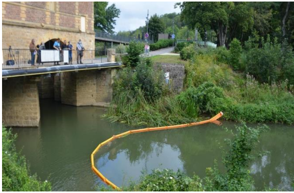
Figure 7 - Exemple des barrages flottants anti-pollution
