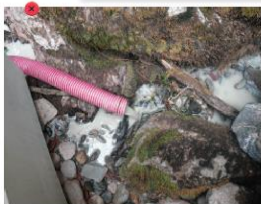
Rejet de laitance béton en milieu naturel.
