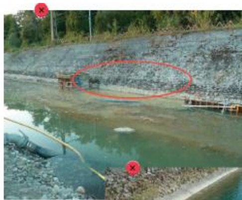
Lessivage de la laitance d'un coffrage suite à un arrêt trop précoce des pompes et pompage incomplet de la laitance dans le bac de traitement.
