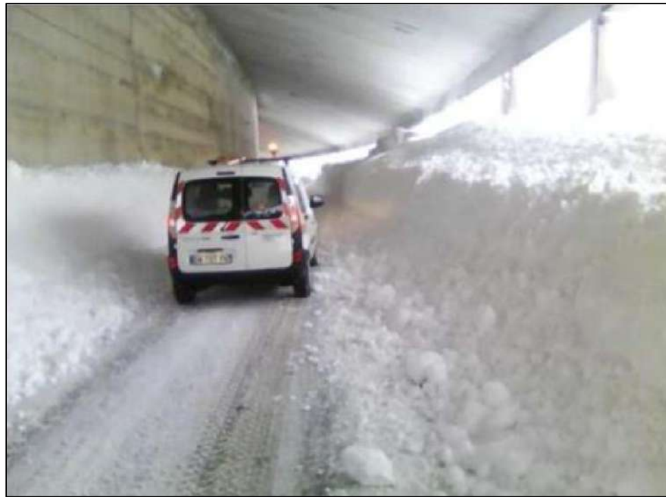
Figure 9 : Conditions d'exploitation de la galerie de la Marionnaise existante dans des conditions hivernales extrêmes
