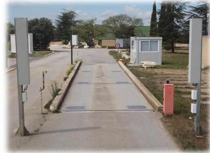
Portique radioactivité et pont bascule
