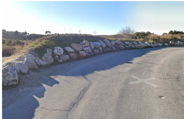
Enrochements et merlons en accotements de voirie contre les quads et moto-cross
