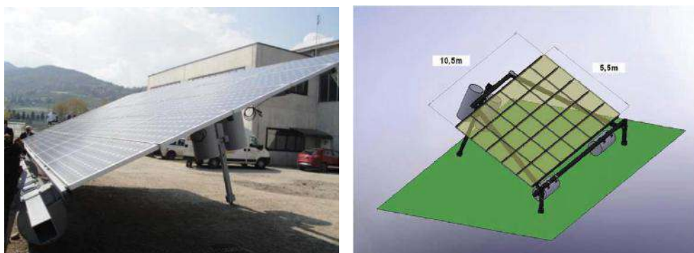
Figure 2 : Voile photovoltaïque et principe d'implantation (source : ESPACE 2014)
