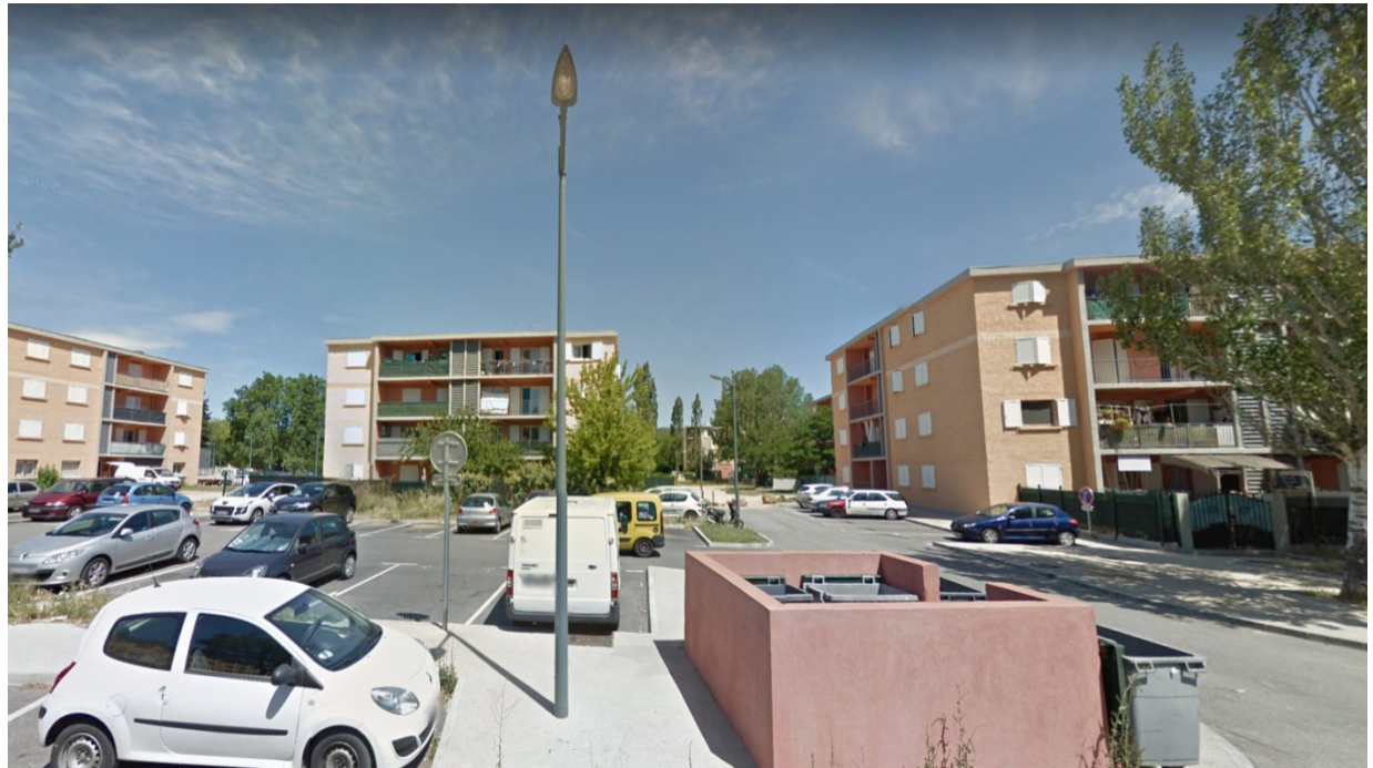
Photographie 3 : Quartier Le Carami à Brignoles – Source : Streetview
