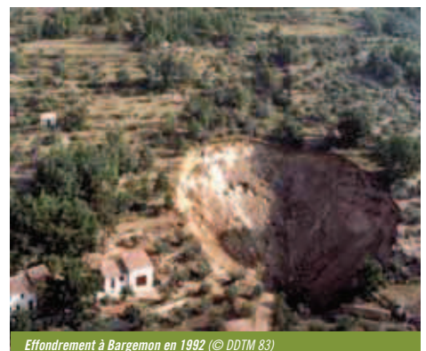
Effondrement à Bargemon en 1992 (© DDTM 83)
