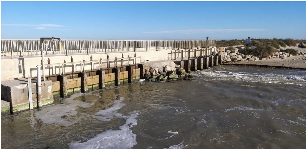
Figure 25. Pertuis de la Fourcade, porte d'entrée de l'eau de mer dans le système Vaccarès
