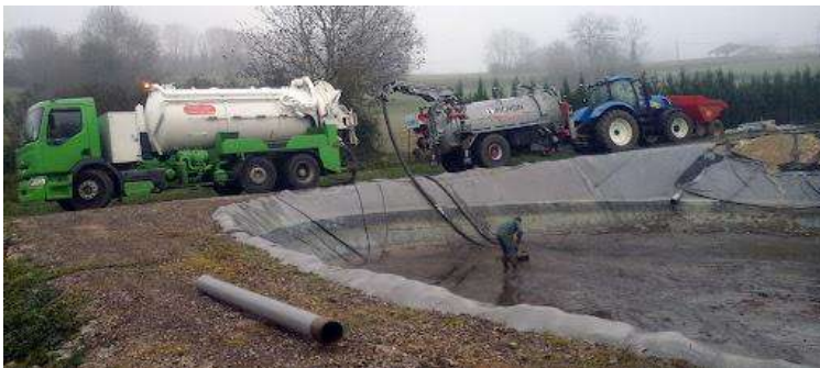
Photo 12. Curage d'un bassin d'orage
