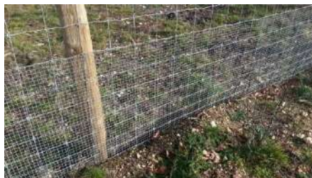
Photo 8. Clôture imperméable à la faune
