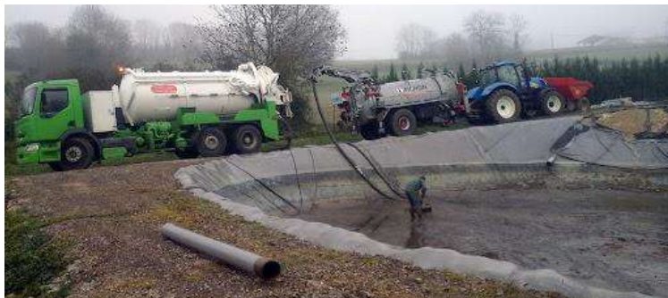
Photo 76. Curage d'un bassin d'orage
