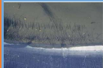
Traces de griffes de mammifères sur une berge bâchée
