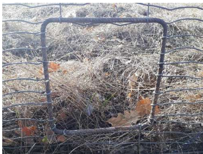
Trouée à la base de la clôture permettant le passage de la petite et moyenne faune.
