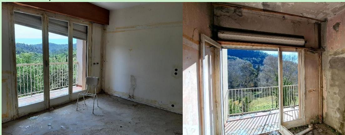
*Photographies d'un caisson de volet roulant fermé (à gauche), et d'un caisson de volet roulant ouvert (à droite) au sein du bâtiment*
