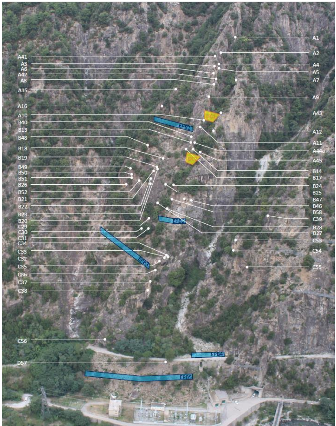
Figure 1 Détail des travaux en falaises, avec 57 aléas et 7 filets pare blocs (Source : Fondasol/ Garelli)
