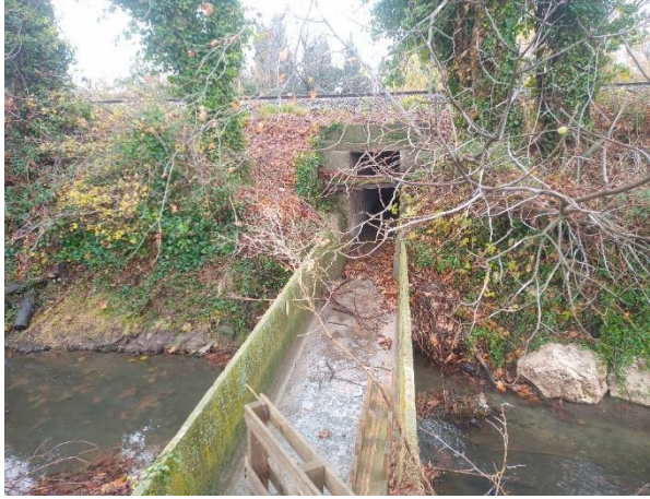
Figure 36 : Ouvrage n°17 côté nord
