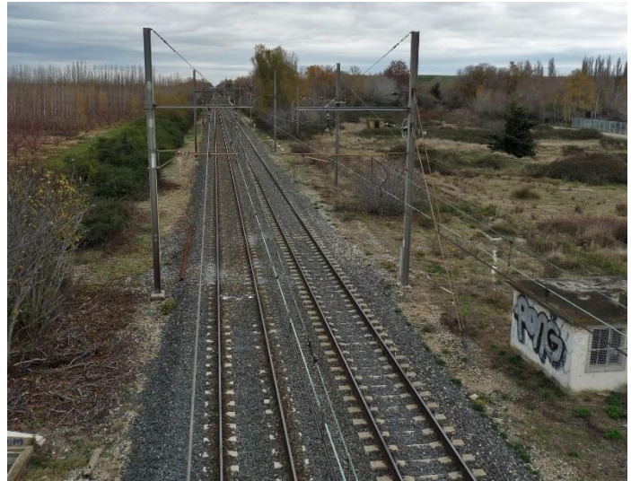
Figure 29 : Voie ferrée au niveau du Centre d'enfouissement de Saint-Martin-de-Crau
