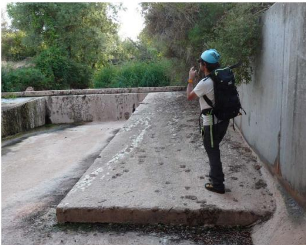
Rampes béton (ici un répartiteur) permettant à la faune de franchir aisément un seuil © Micaël CENDROT
