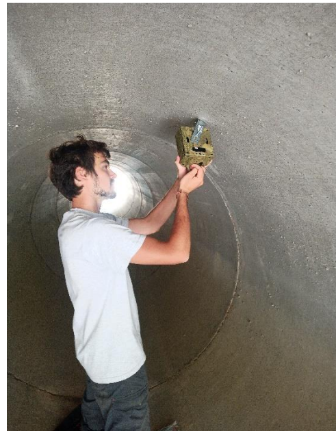
Figure 49 : Instrumentation en cours d'un ouvrage sous la voie ferrée
