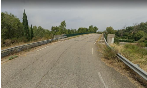
Figure 22 : Ouvrage n°2 favorable à l'installation de banquettes à faune sur les côtés.
