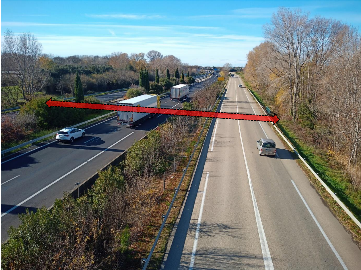
Figure 26 : L'ouvrage n° 1, non expertisé à cause de la végétation et des propriétés privées, traverse l'A54 et la D113, ce qui lui confère une grande importance pour la TVB dans ce secteur
