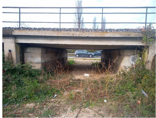
Figure 44 : Ouvrage n°25 , fonctionnel mais débouchant sur la RD69
