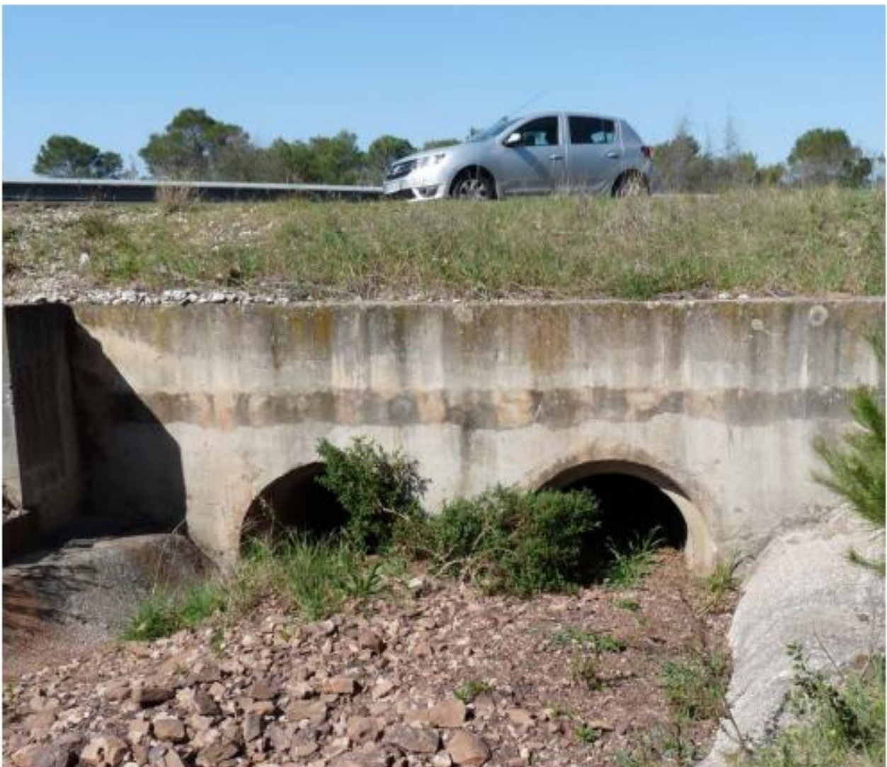
Busés ayant perdues un tiers de leur hauteur utile par engrèvement © Micaël GENDROT
