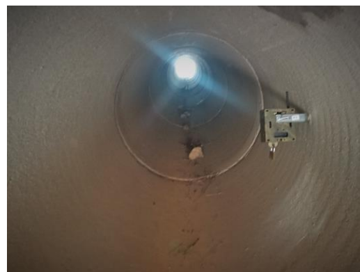
Figure 51 : : Étude en cours d'un ouvrage sous la voie ferrée pour connaître quelles espèces utilisent ce type d'ouvrage
