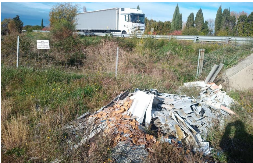
Figure 17 : Dépôts sauvages devant à l'entrée sud de l'ouvrage n°35
