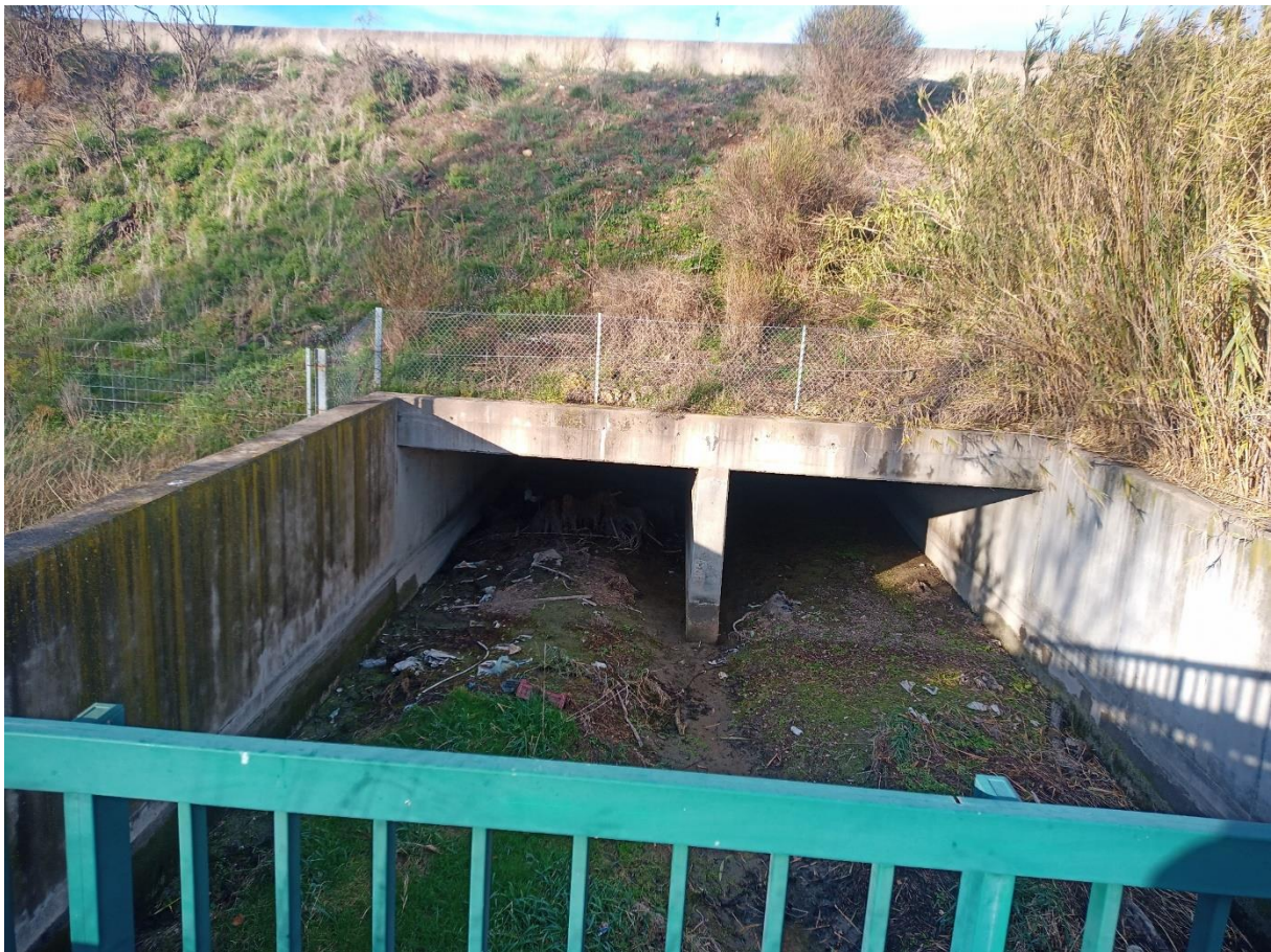
Figure 20 : Ouvrage n°16 : Canal du Grand Brahis
