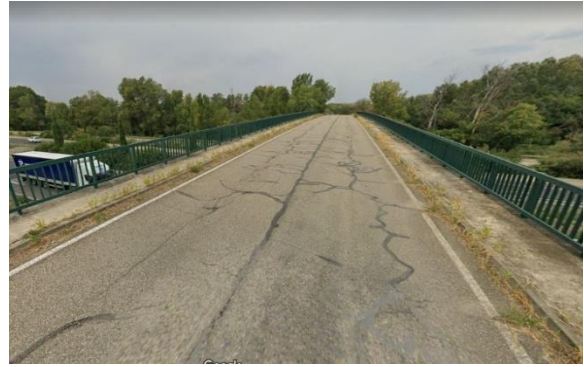
Figure 28 : Ouvrage 2 : aménager des banquettes pour rendre ce pont route attractif pour la faune
