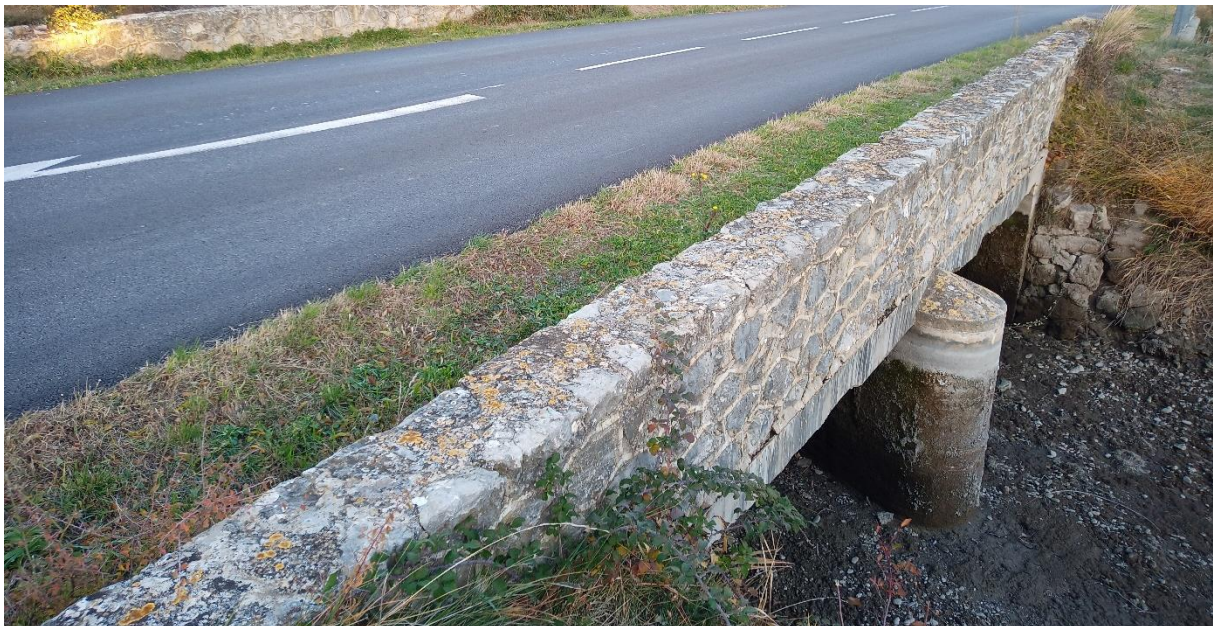
Figure 48 : Passage du canal des Garrigues sous la RD17 à l'ouest d'Eyguières. Cet ouvrage est en eau le reste de l'année et ses démentions ne permettent pas d'envisager l'installations de passages à pieds secs type banquettes ou encorbellement.
