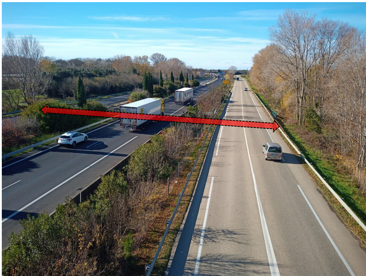
Figure 21 : L'ouvrage n° 1, non expertisé à cause de la végétation et des propriétés privées, traverse l'A54 et la D113, ce qui lui confère une grande importance pour la TVB dans ce secteur
