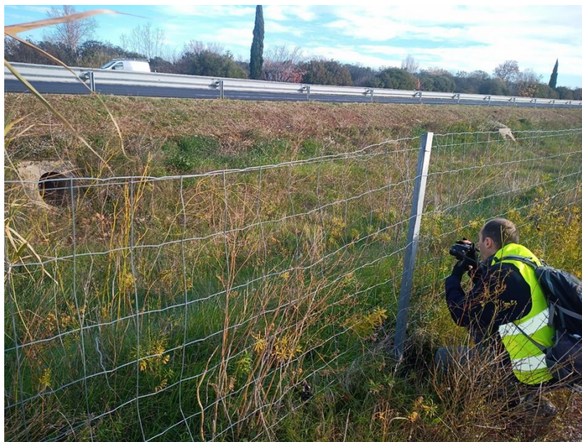
Figure 13 : Exemple de descente d'eau non fonctionnelle pour la faune sauvage
