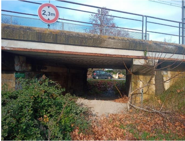
Figure 43 : Ouvrage n°21 , fonctionnel mais débouchant sur la RD69
