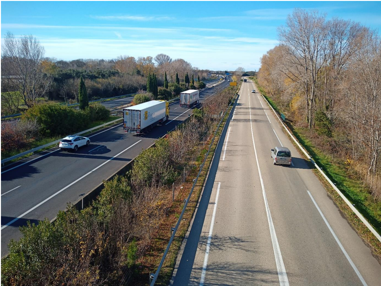
Figure 10 : A54 (à gauche) et RD113 (à droite) aux portes de Saint-Martin-de-Crau © N. Fuento
