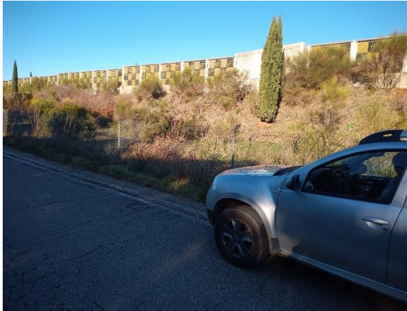
Figure 18 : Ouvrage n°31 : talus intéressant pour la création d'un écoduc
