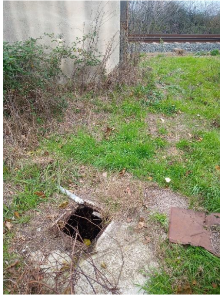
Figure 34 : Ouvrage n°9 : Cuve ouverte présentant un risque important de piégeage accidentel pour la faune sauvage
