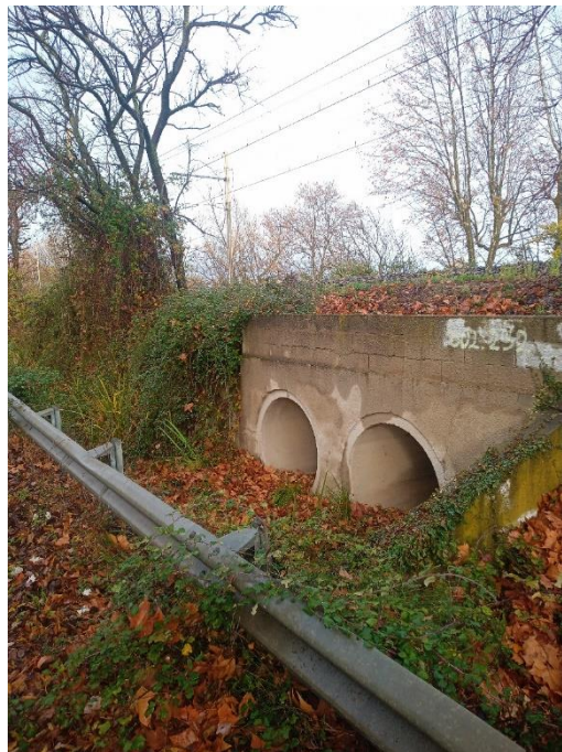
Figure 35 : Ouvrage n°12 à aménager pour le rendre parfaitement fonctionnel pour l'ensemble de la faune terrestre
