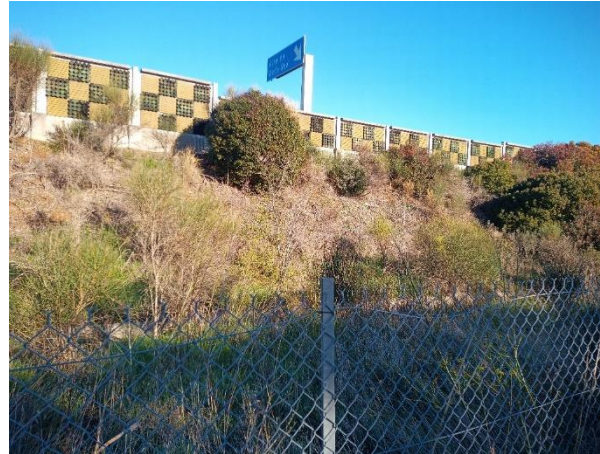
Figure 19 : Ouvrage n°31 : talus intéressant pour la création d'un écoduc
