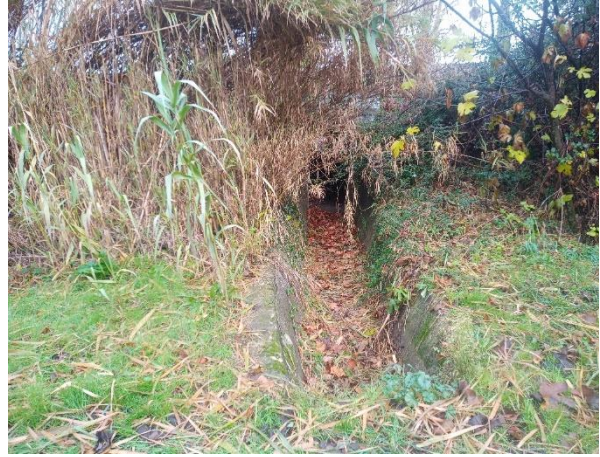
Figure 37 : Ouvrage n°17 côté sud
