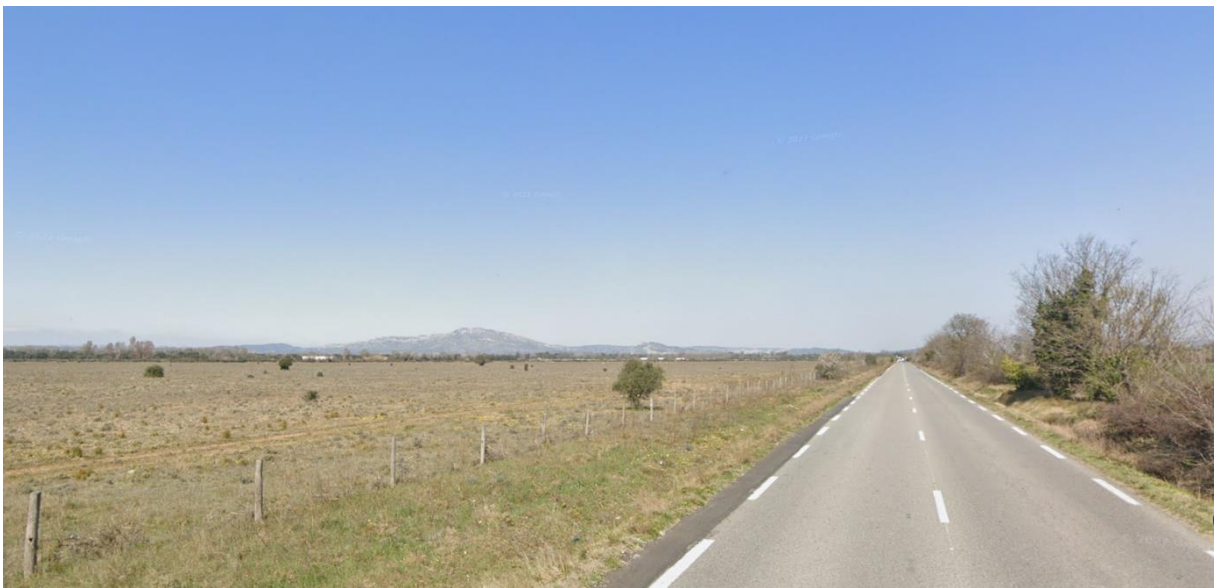
Figure 45 : RD569 traversant la RNR Poitevine-Regarde-Venir. Aucun ouvrage d'art n'a été observé et la topographie plane ne permet actuellement pas la création de nouveaux aménagements
