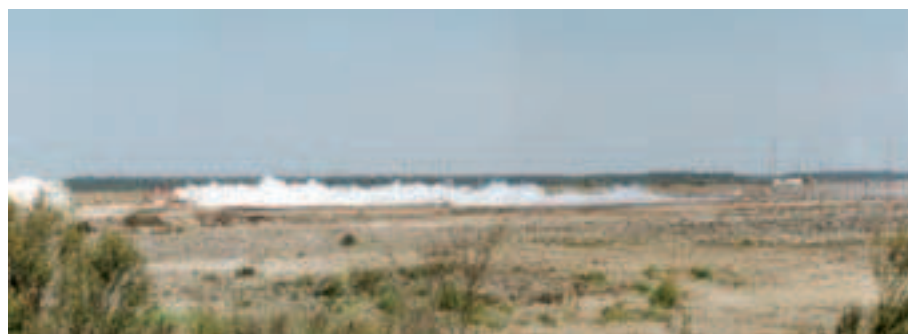
Fig. 10 - Relâchement d'ammoniac suite à une rupture de canalisation
