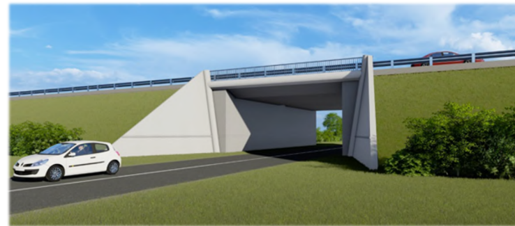
Illustration : ouvrage de transparence sous l'infrastructure, pour la traversée des véhicules (source : DREAL)
