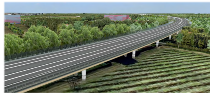
Illustration : ouvrage de transparence hydraulique sous l'infrastructure, pour le bon écoulement des eaux en cas de crue (source : DREAL)
