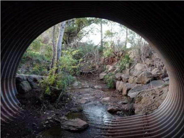
Sortie sud de l'ouvrage © Micaël GENDROT
