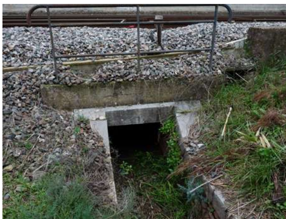
L'ouvrage n°9 est un dalot dont les extrémités sont entourées de murets © Micaël GENDROT
