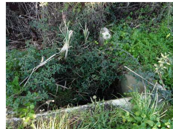
Ouvrage n°12 vu du dessus © Micaël GENDROT
