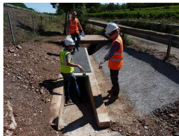
Réunion de chantier au niveau d'une rampe en pente douce créée © Micaël GENDROT
