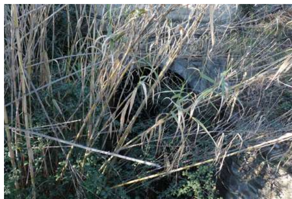
Ouvrage n°67 que l'on devine derrière les cannes © Micaël GENDROT
