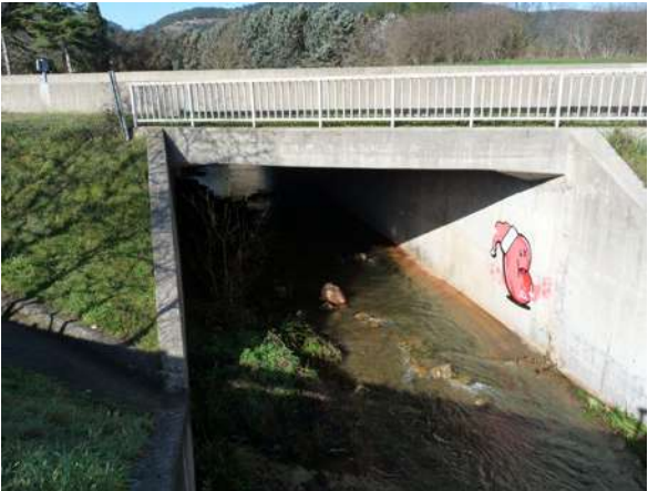
Pont sur l'Aille, ouvrage n°9 © Micaël GENDROT
