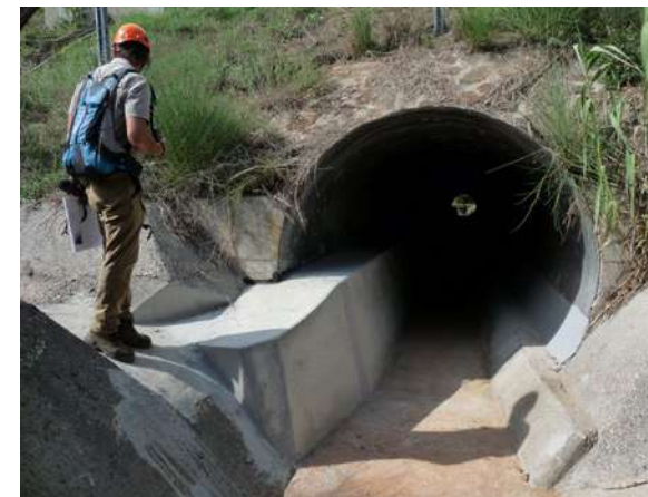
Trottoir créé dans la buse de l'Aille © Micaël GENDROT
