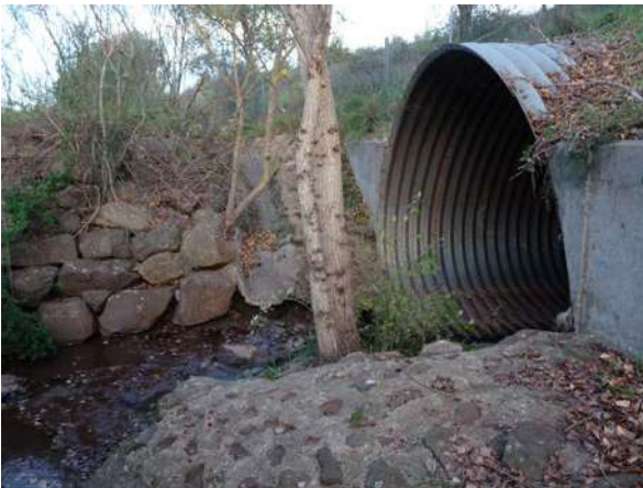
Enrochement sur les berges © Micaël GENDROT
