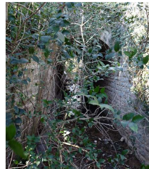
Ouvrage n°74 un peu masqué par la végétation © Micaël GENDROT
