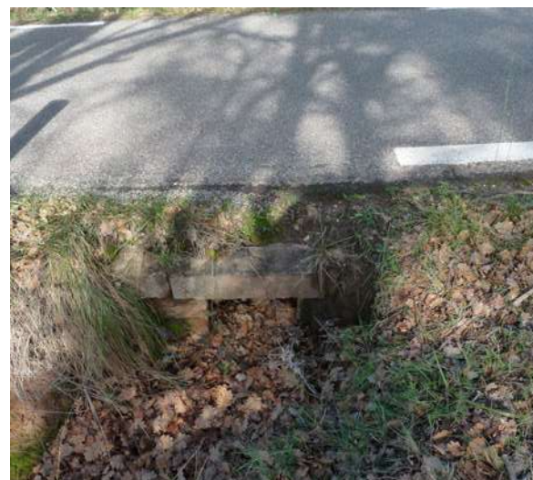
L'ouvrage n°5 est un dalot qui était partiellement obstrué lors de la prospection © Micaël GENDROT
