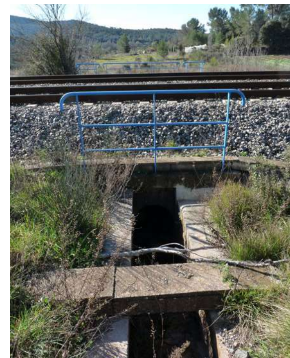
Entrée nord de l'ouvrage n°45 © Micaël GENDROT
