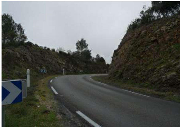
Zone permettant la mise en place d'une passerelle © Micaël GENDROT
