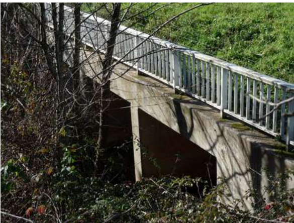
Vue du dessus de l'ouvrage n°14 © Micaël GENDROT
