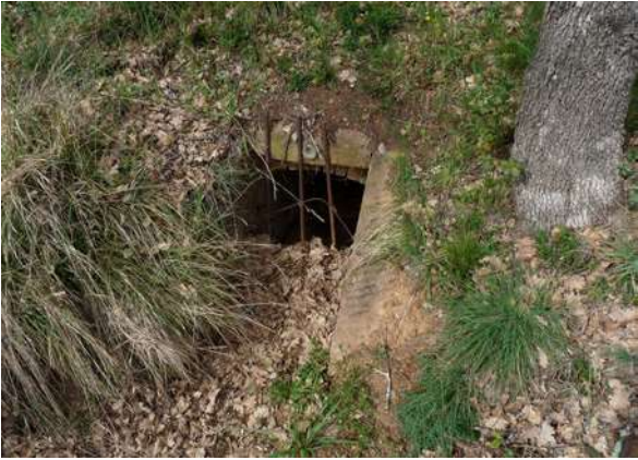
Barreaux de l'ouvrage n°11 © Micaël GENDROT
