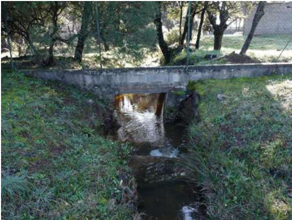
Ouverture dans la clôture en aval © Micaël GENDROT
