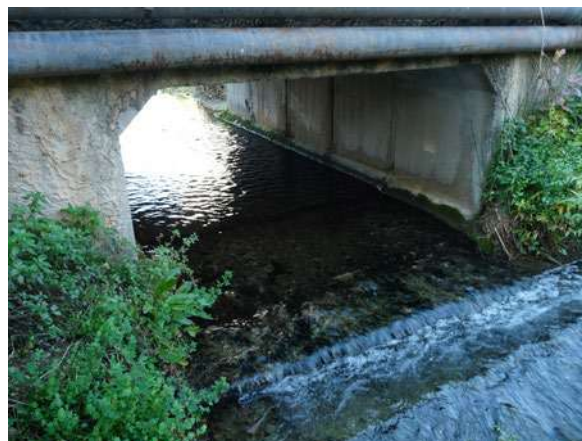
Écoulement sur toute la largeur de l'ouvrage © Micaël GENDROT
