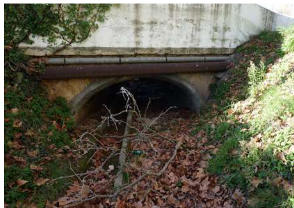
Entrée amont de l'ouvrage n°3 © Micaël GENDROT
