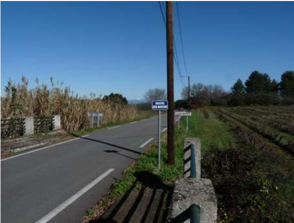
Vue de la chaussée au niveau de l'ouvrage n°1 © Micaël GENDROT
