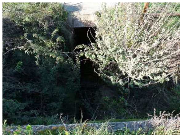
Ouvrage n°18 vu du dessus © Micaël GENDROT
