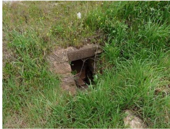
Avaloir à l'entrée de l'ouvrage n°5 © Micaël GENDROT
