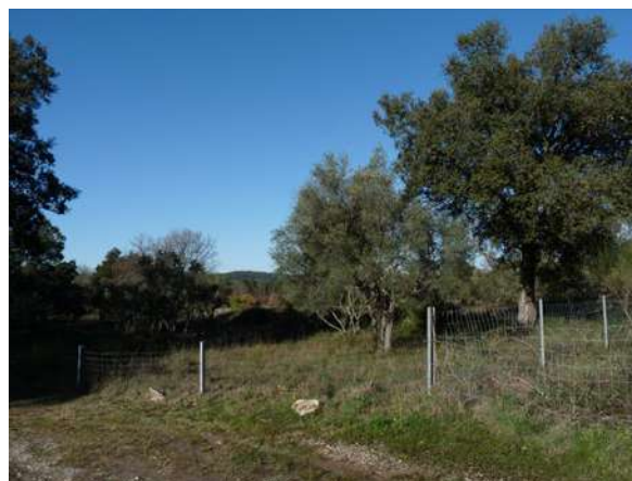
Clôture en partie endommagée au nord-est de l'ouvrage n°28 © Micaël GENDROT
