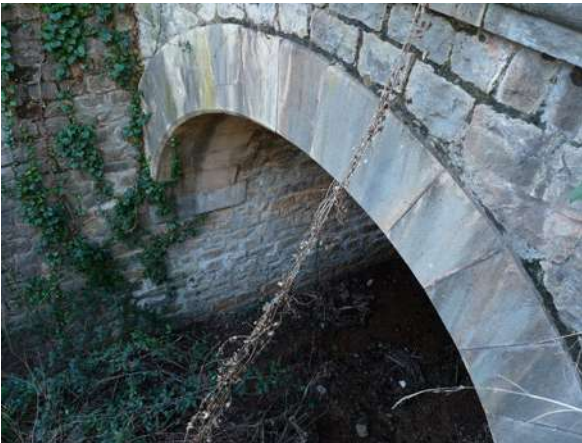
Ouvrage n°78, vue du dessus et permettant de voir un passage à pied sec sur la berge droite © Micaël GENDROT
