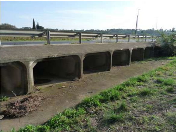
Sortie nord du pont cadre © Micaël GENDROT
