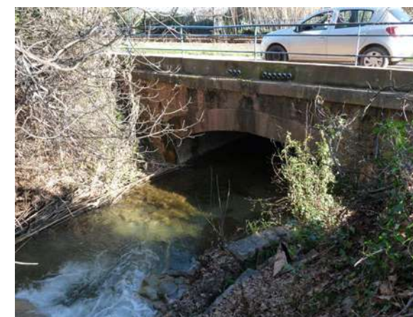
Ouvrage n°72, passage du cours d'eau © Micaël GENDROT
