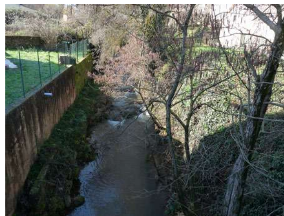
Berges amont de l'ouvrage n°4 © Micaël GENDROT
