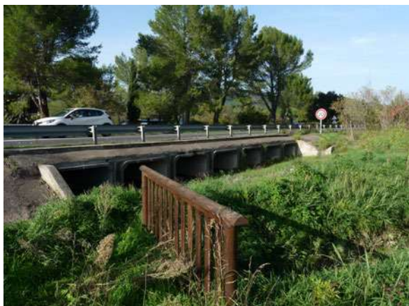
Pont d'accès à l'ouvrage au-dessus d'un fossé qui le longe et passe sous la route à l'est © Micaël GENDROT
