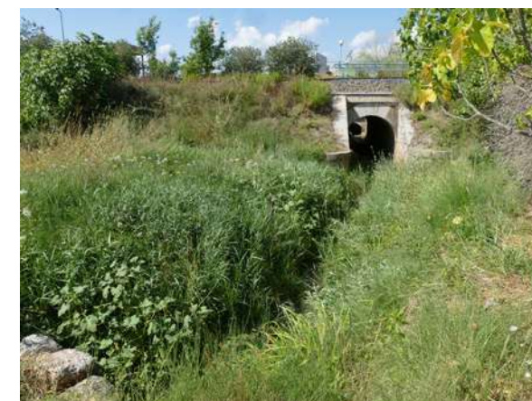
Ouvrage n°38 côté sud. La naturalité des abords et les dimensions de l'ouvrage le rendent accessible pour la faune sauvage. © Nicolas FUENTO
