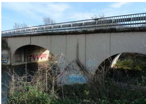
Pont de la RD13 sur l'Issole (ouvrage n°2) © Micaël GENDROT
