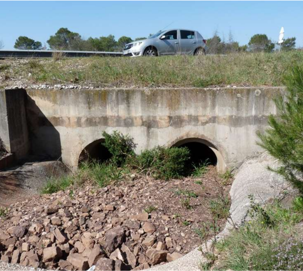
Buses ayant perdues un tiers de leurs hauteur utile par engravement © Micaël GENDROT
