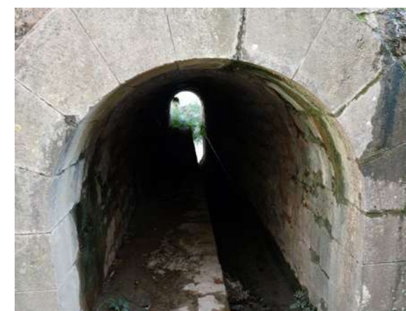
Ouvrage n°72, passage du canal © Micaël GENDROT
