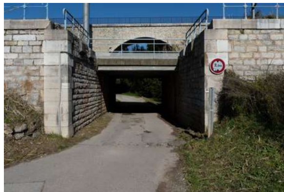
Ouvrage n°53 au premier plan, suivi du viaduc qui constitue l'ouvrage n°54 © Micaël GENDROT
