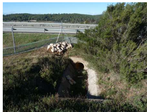
Clôture petite faune, andain à reptile et blocs disposés afin de faciliter l'accès à la buse pour les animaux © Micaël GENDROT
