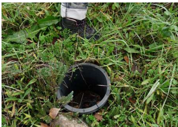
Réservation constituant un piège pour la petite faune © Micaël GENDROT
