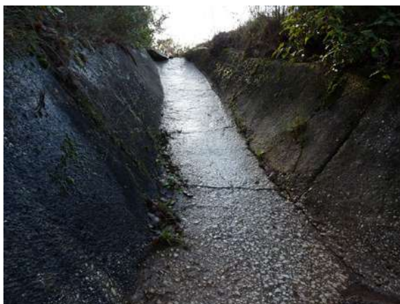
Caniveau béton en amont de l'ouvrage n°27 © Micaël GENDROT
