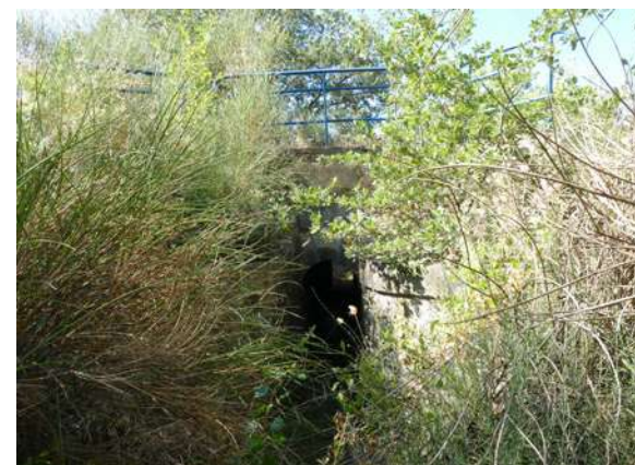
Entrée sud de l'ouvrage n°36 © Nicolas FUENTO
