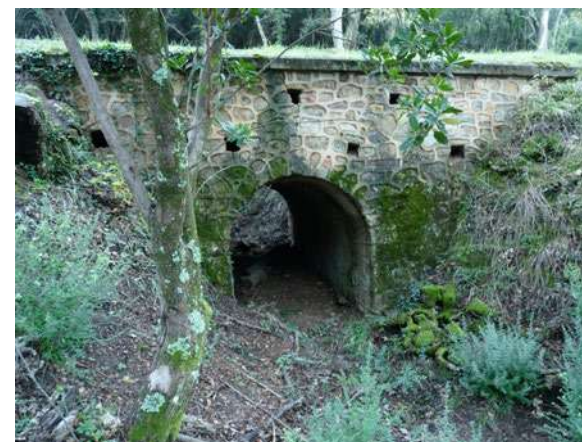
Ouvrage n°15 aux ouvertures dégagées © Micaël GENDROT
