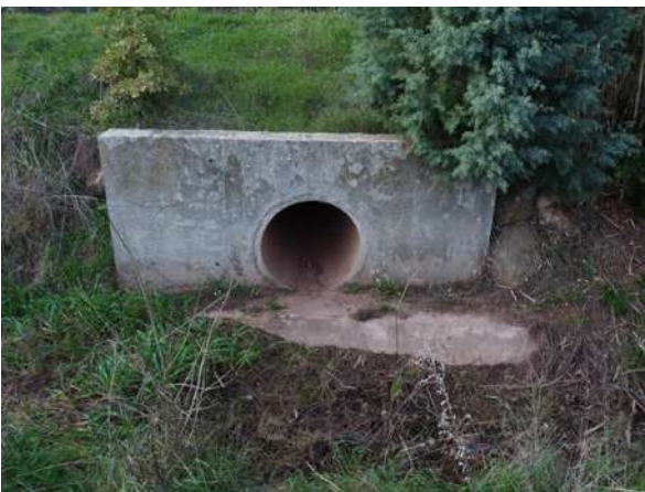
Ouvrage 6 au pied du talus © Micaël GENDROT
