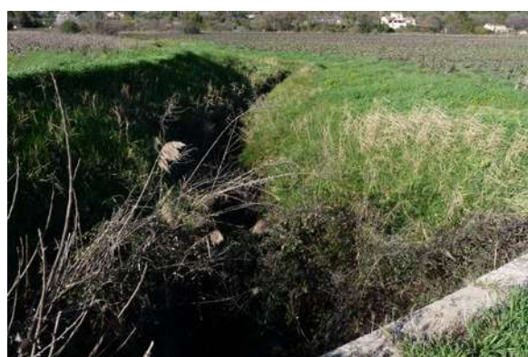
Berges abruptes du ruisseau à l'amont de l'ouvrage n°71 © Micaël GENDROT
