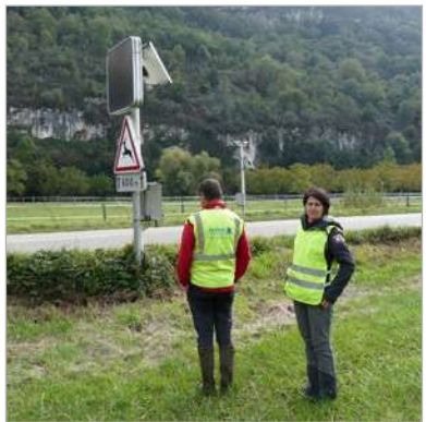
Signalisation couplée à un système de détection
