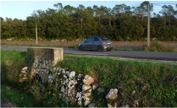
Murs en pierre autour de l'ouvrage n°1 © Micaël GENDROT
