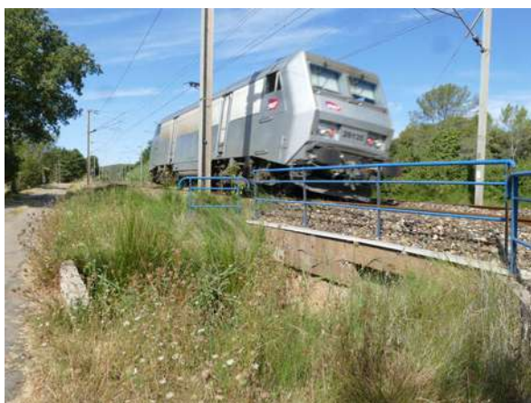
Entrée sud de l'ouvrage n°31 © Nicolas FUENTO
