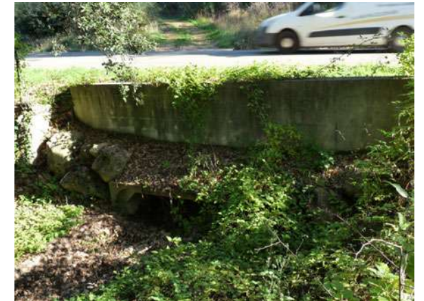
Cadre béton à l'amont de l'ouvrage n°7 © Micaël GENDROT
