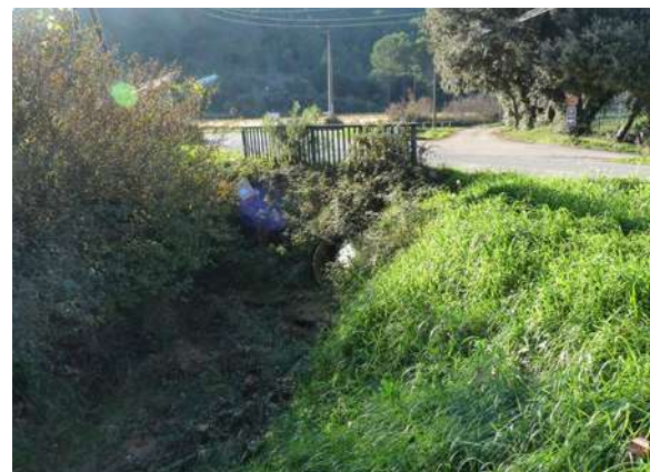
Sortie est, partiellement obstruée par la végétation © Micaël GENDROT
