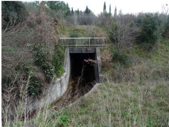
Vue du côté nord de l'ouvrage n°58 © Micaël GENDROT
