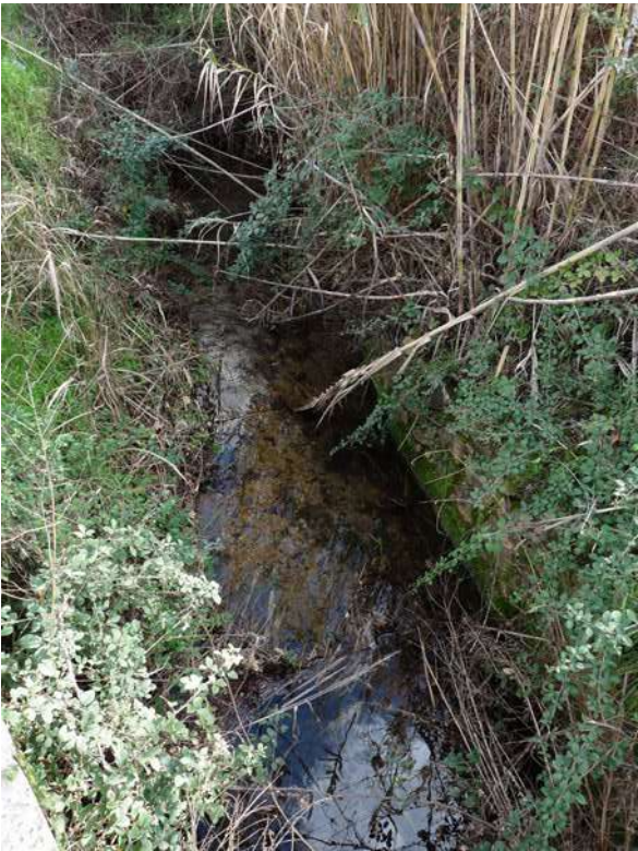
Ruisseau en amont de l'ouvrage n°6 © Micaël GENDROT
