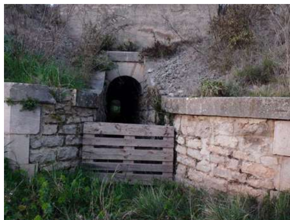
Palette en bois condamnant l'accès à l'ouvrage n°41 © Micaël GENDROT
