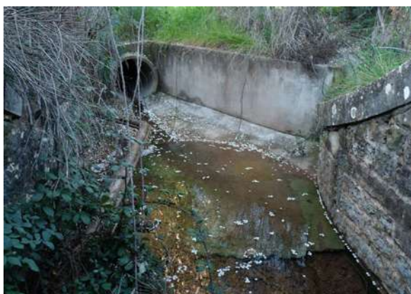
Amont de l'ouvrage n°65 avec présence d'une buse de 80 cm de diamètre © Micaël GENDROT
