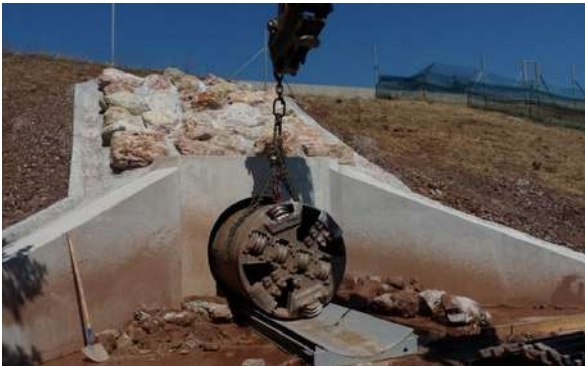
Ecoducs de la Pardiguière (A57), extraction du micro tunnelier © M GENDROT
