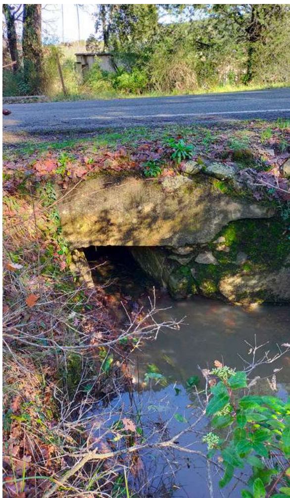
Ouvrage n°10 © A. PAPET
