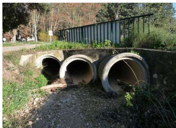
Extrémité ouest de l'ouvrage n°4 © Micaël GENDROT
