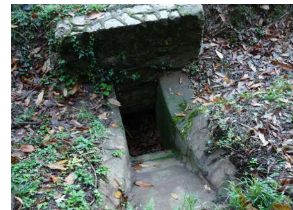
Avaloir de l'ouvrage n°18 © Micaël GENDROT
