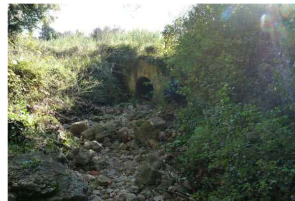
Amont de l'ouvrage facilement accessible © Micaël GENDROT
