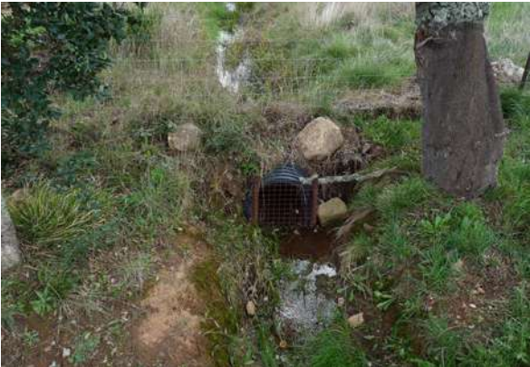
Grille devant l'ouvrage n°12 © Micaël GENDROT
