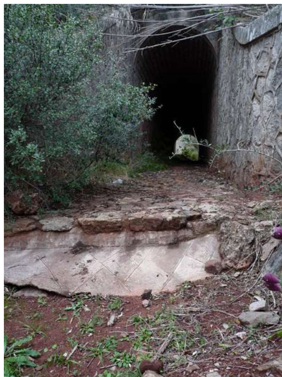
Marche difficilement franchissable par la Tortue d'Hermann au niveau de l'ouvrage n°13 © Nicolas FUENTO
