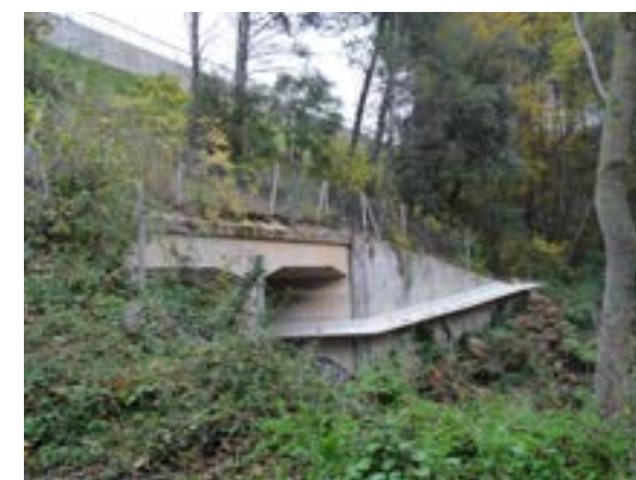
Exemple d'encorbellement réalisé sous un ouvrage d'art sur la commune d'Auriol © Micaël GENDROT
