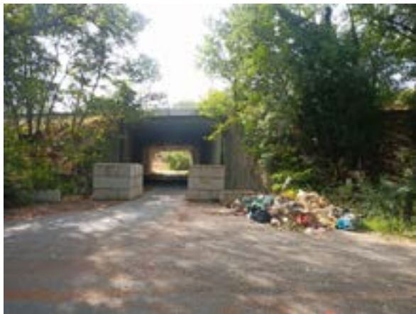
Ouvrage n°33 © Nicolas FUENTO
