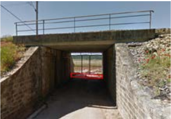
Ouvrage n°63. Le cadre rouge représente l'ouverture qu'il est nécessaire de faire pour restituer le passage à la petite et moyenne faune terrestre © Nicolas FUENTO
