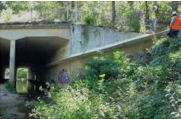
Exemple d'encorbellement réalisé sous un ouvrage d'art sur la commune d'Auriol © Micaël GENDROT
