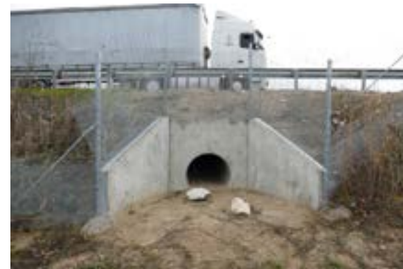
Exemple de grillage petite faune qui encadre parfaitement les entrées d'un ouvrage Vinci © Nicolas FUENTO
