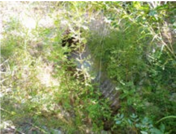
Ouvrage n°7 © Nicolas FUENTO
