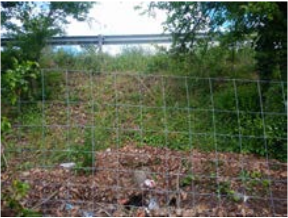
Ouvrage n°34 enseveli sous les feuilles mortes et la végétation © Nicolas FUENTO
