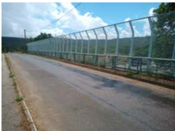
Ouvrage n°39 © Nicolas FUENTO
