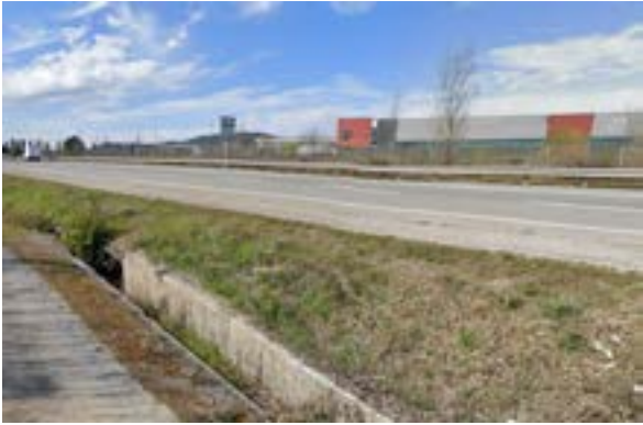
Ouvrage n°4 vue générale © Nicolas FUENTO
