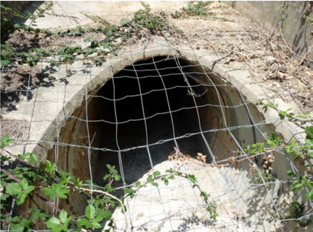
Buse parfaitement fonctionnelle pour la faune malheureusement condamnée par un grillage © Micaël GENDROT
