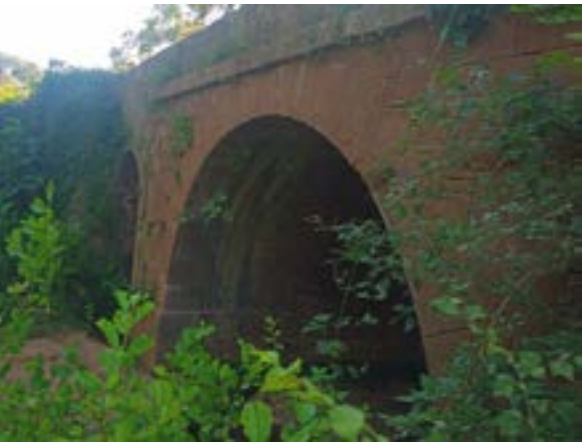
Ouvrage n°1 © Nicolas FUENTO
