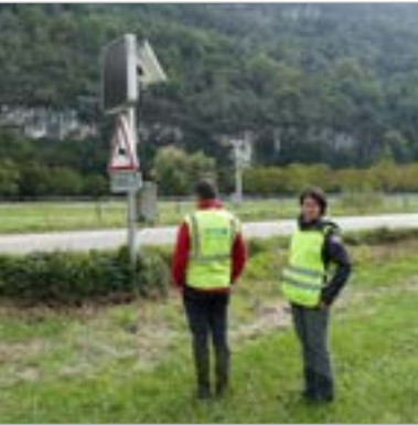
Signalisation couplée à un système de détection
