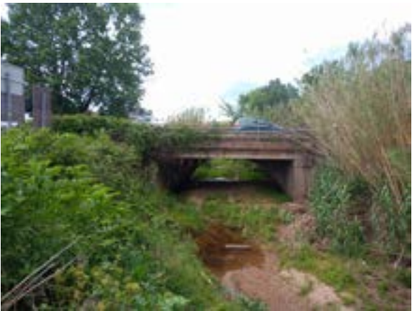
Ouvrage n°3, le passage du Réal © Nicolas FUNETO
