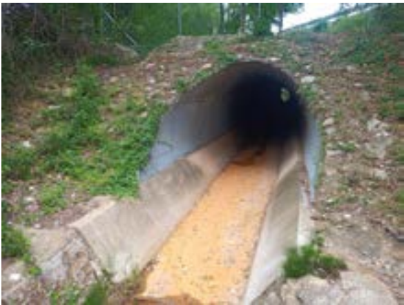
Ouvrage n°35 © Nicolas FUENTO
