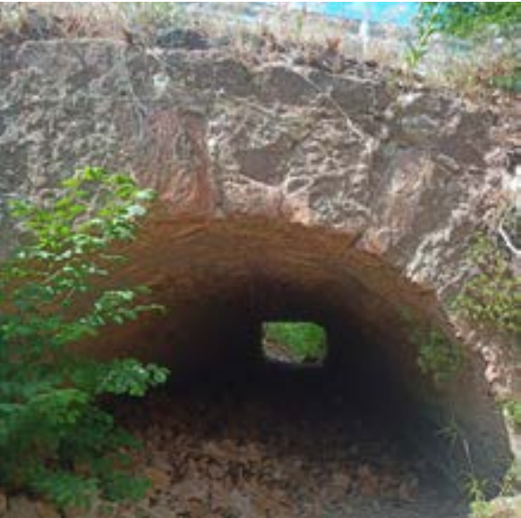
Ouvrage n°1 © Nicolas FUENTO
