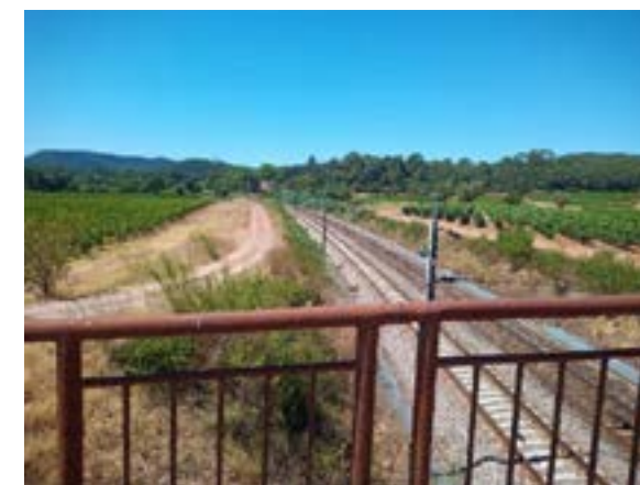
Voie ferrée sur la commune de Taradeau au sein d'un paysage mêlant viticulture et espaces naturels © Nicolas FUENTO
