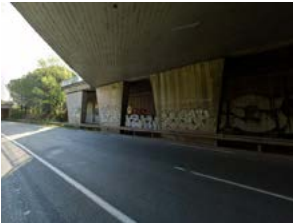
Ouvrage n°4 : vue sur les piles du pont qui pourraient servir à fixer des panneaux occultants © Nicolas FUENTO
