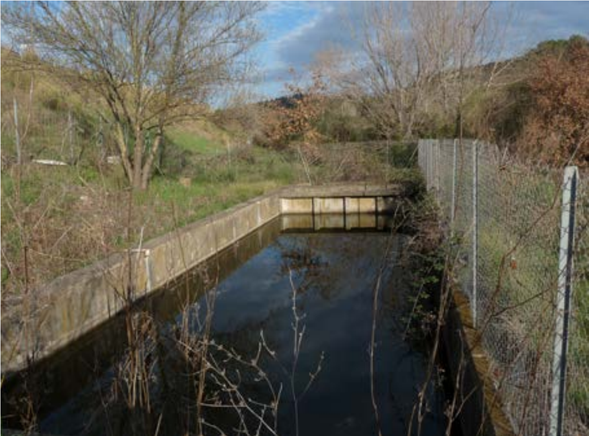
Exemples de bassins de rétention pouvant être dangereux pour la faune : berges verticales © Micaël GENDROT
