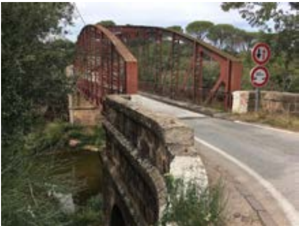
Ouvrage n°1 « Pont de fer sur l'Aille » © Nicolas FUENTO
