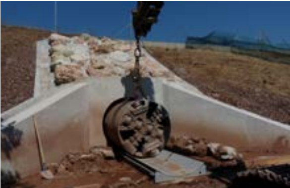
Ecoducs de la Pardiguière (A57), extraction du micro tunnelier © Micaël GENDROT
