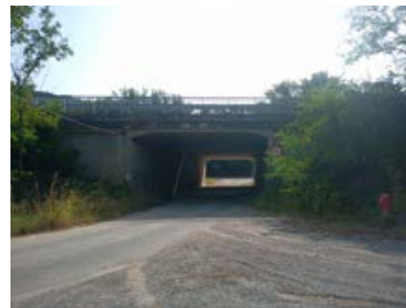
Ouvrage n°29 © Nicolas FUENTO
