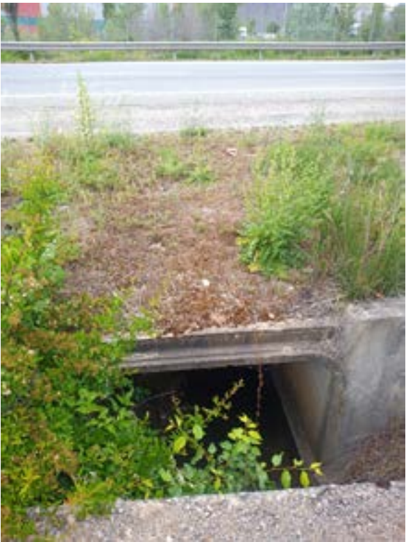
Ouvrage n°4 © Nicolas FUENTO
