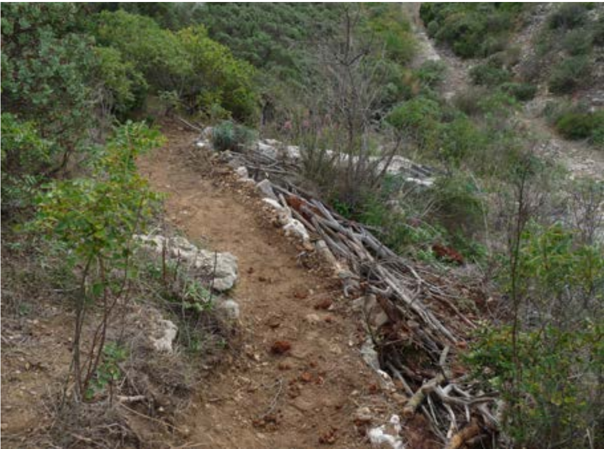
Rampe d'accès adaptée à la faune à un ouvrage © Micaël GENDROT
