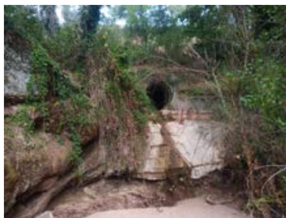
Ouvrage n°28 difficile d'accès pour la faune terrestre © Nicolas FUENTO
