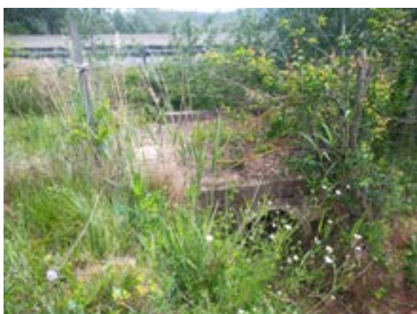
Ouvrage n°40 © Nicolas FUENTO
