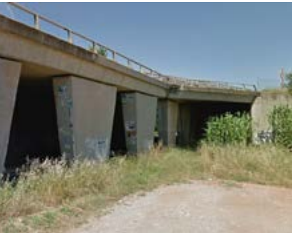
Ouvrage de franchissement accolé à la RN7 © Nicolas FUENTO
