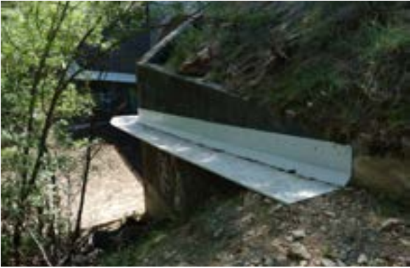
Exemple de banquettes en encorbellement aménagées sous un ouvrage dans les Bouches-du-Rhône © Micaël GENDROT
