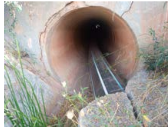
Ouvrage n°12 avec gros tuyau de 200 mm de diamètre à l'intérieur © Nicolas FUENTO
