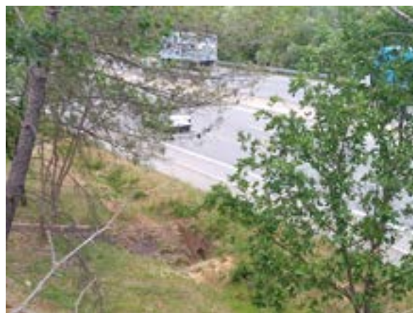
Ouvrage n°43 © Nicolas FUENTO
