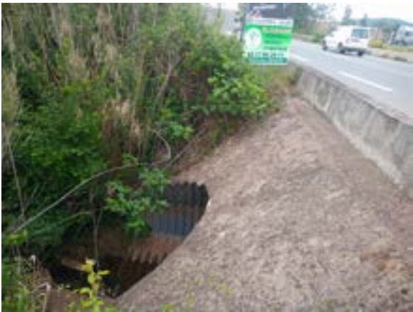
Ouvrage n°5 © Nicolas FUENTO
