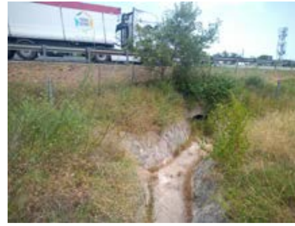
Ouvrage n°23 © Nicolas FUENTO
