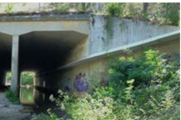
Exemple d'encorbellement dans un ouvrage d'art sur la commune d'Auriol (13) © Micaël GENDROT
