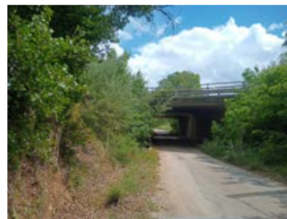
Ouvrage n°36 © Nicolas FUENTO
