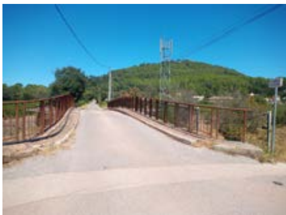
Ouvrage n°33 © Nicolas FUENTO
