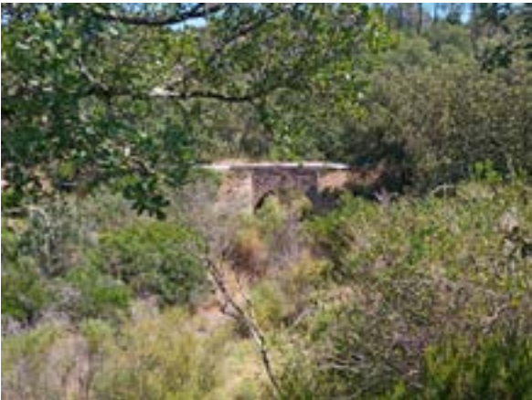
Ouvrage n°4 © Nicolas FUENTO
