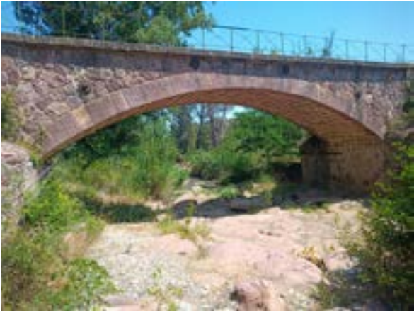
Ouvrage n°2 © Nicolas FUENTO
