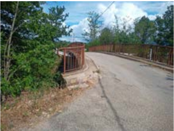
Ouvrage n°63 © Nicolas FUENTO
