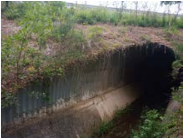
Ouvrage n°42 © Nicolas FUENTO
