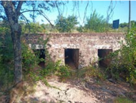
Ouvrage n°2 © Nicolas FUENTO
