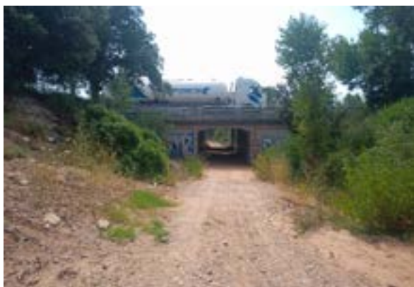
Ouvrage n°26 © Nicolas FUENTO
