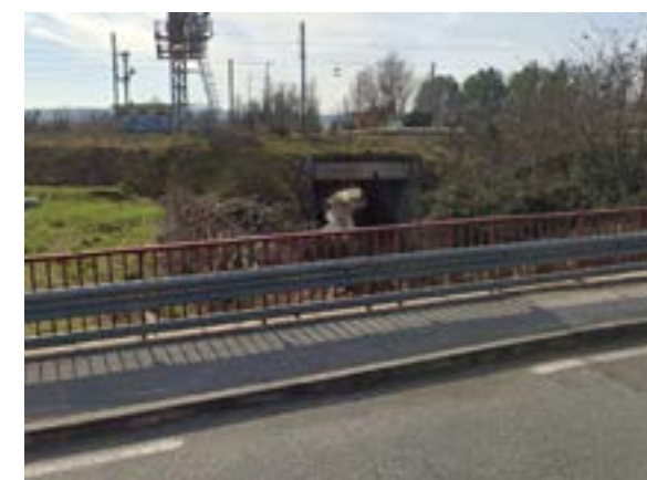
Ouvrage n°44 © Nicolas FUENTO
