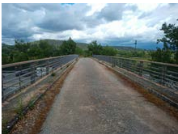
Ouvrage n°44 © Nicolas FUENTO
