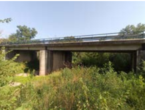
Ouvrage n°3 © Nicolas FUENTO
