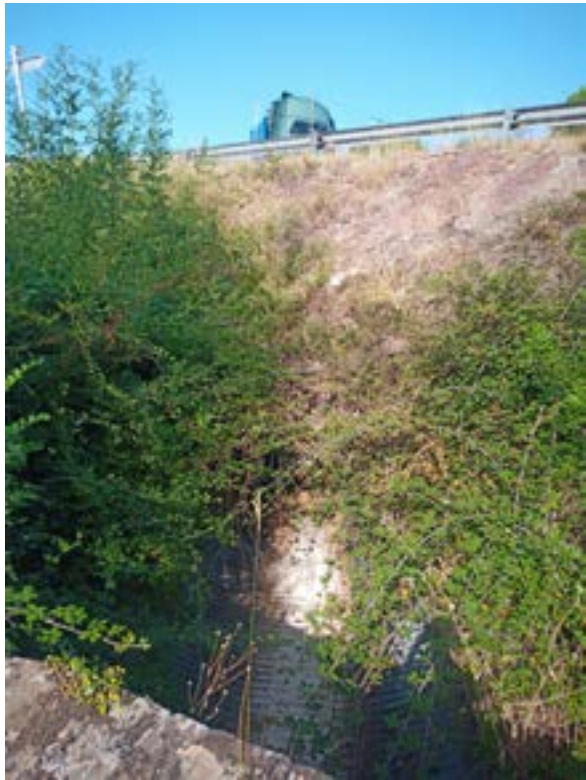
Ouvrage n°3 © Nicolas FUENTO
