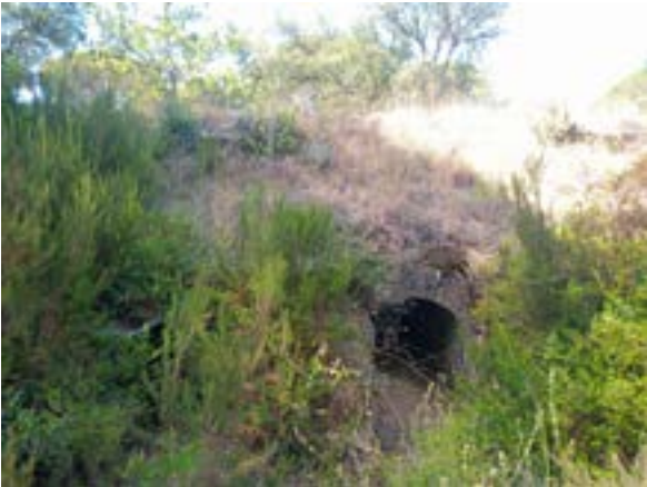
Ouvrage n°3 © Nicolas FUENTO
