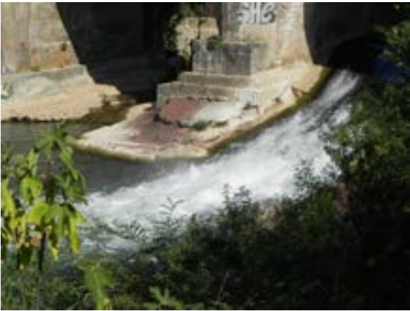
Ouvrage n°2 vu depuis l'hôtel Aurélia (rive gauche). Zoom sur l'ouvrage hydraulique) © Nicolas FUENTO
