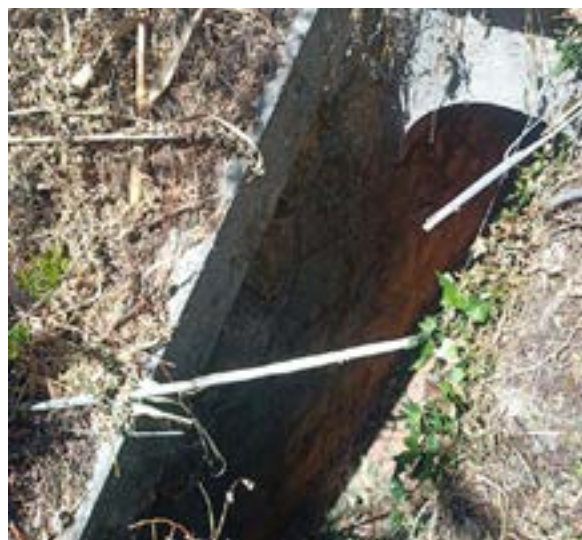
Ouvrage n°38 © Nicolas FUENTO
