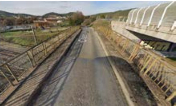
Ouvrage n°45 © Nicolas FUENTO
