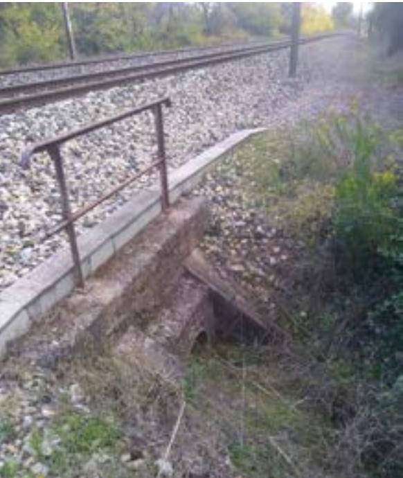
Ouvrage n°6 © Nicolas FUENTO
