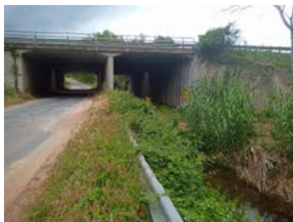
Ouvrage n°41. Ouvrage mixte permettant les passages du Chemin du Bac et du Réal sous l'A8 © Nicolas FUENTO
