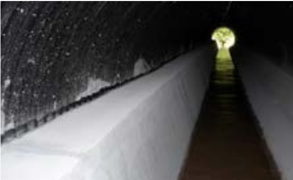
Trottoir construit dans la buse de l'Aille (A57) © Micaël GENDROT
