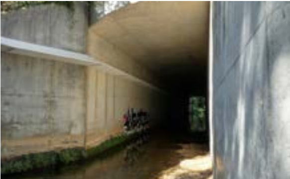
Passage en encorbellement de l'Huveaune (A52) © Micaël GENDROT
