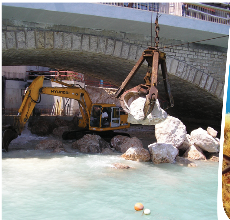
Travaux nécessitant potentiellement un dossier IOTA (©Egis)
