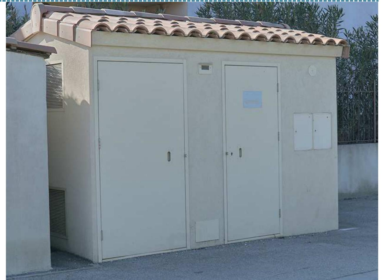
Figure 57 - Référence visuelle d'un poste de transformation crépi et tuilé
