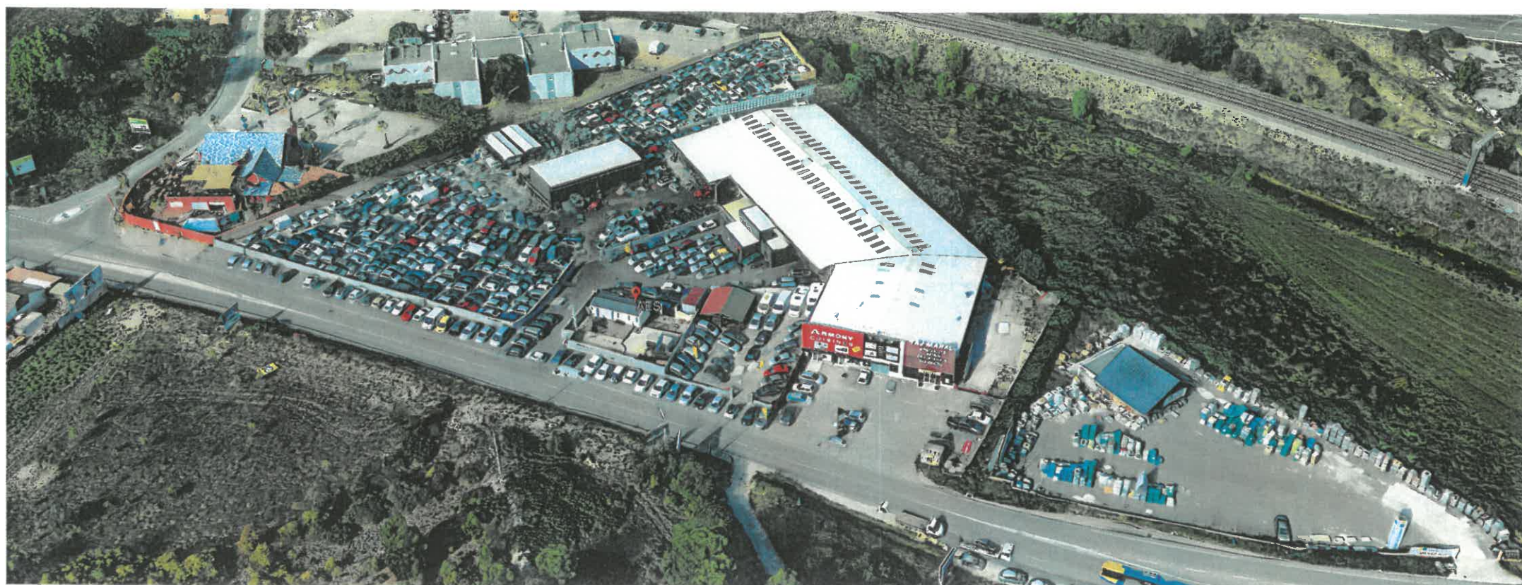
Vue aérienne - EXISTANT
