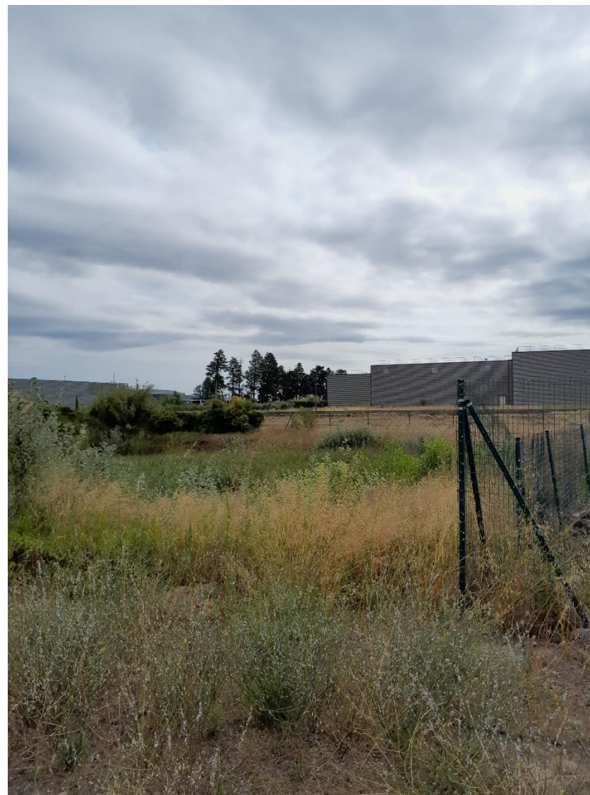
Photographie 12 : Bassin de rétention au nord-est du site
