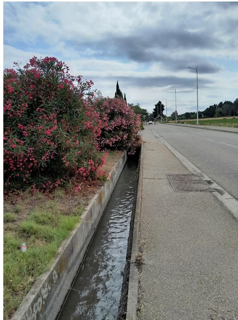
Photographie 2 : Canal au sud du site
