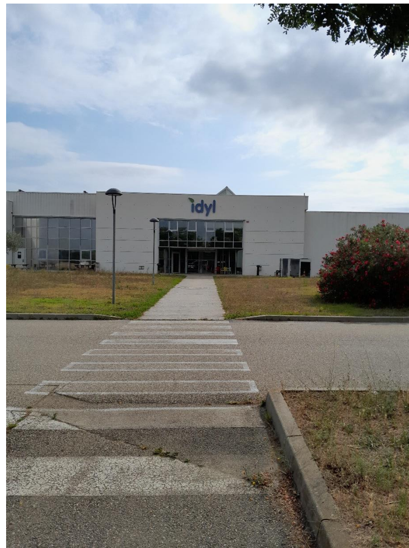
Photographie 4 : Entrée du bâtiment existant
