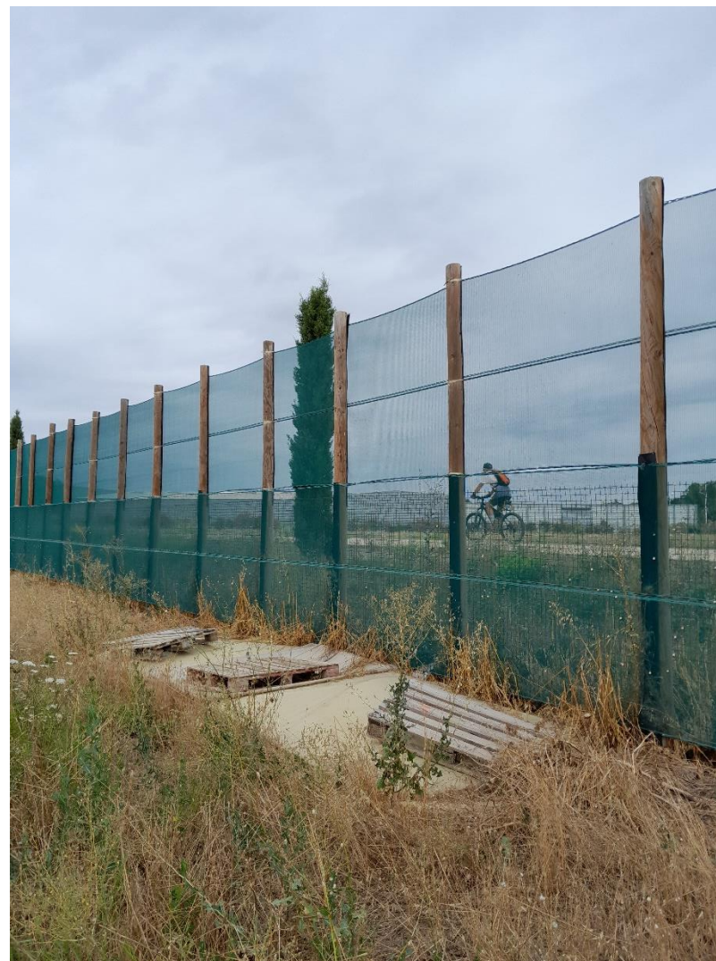
Photographie 10 : Piste cyclable au nord vue du site
