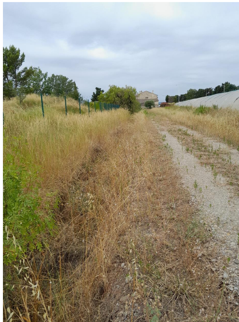
Photographie 8 : Fossé longeant la piste au sud des serres
