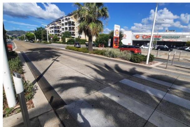
**Photographie 6 : Caniveaux à grille de collecte des eaux pluviales au droit de l'Avenue Francis Tonner**
