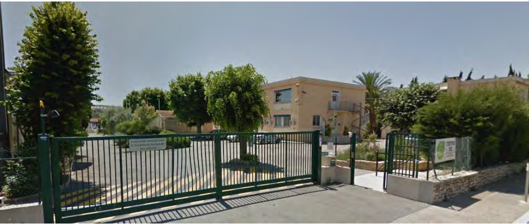
Vue depuis l'accès actuel ( contre allée Francis Tonner )
