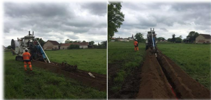
FIGURE 1 : EXEMPLE DE CHANTIER D'ENFOUISSEMENT D'UN RESEAU ELECTRIQUE EN TERRES AGRICOLES (SOURCE : CEGELEC INFRA)
