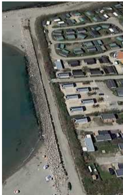
Photo 1. Vue de l'extrémité ouest de la protection
