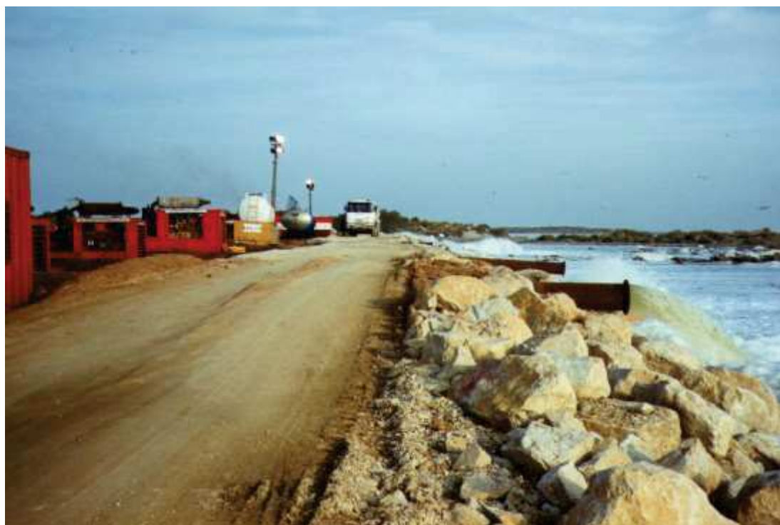
Photo 18. Pompage d'urgence sur la digue à la mer - 1993
