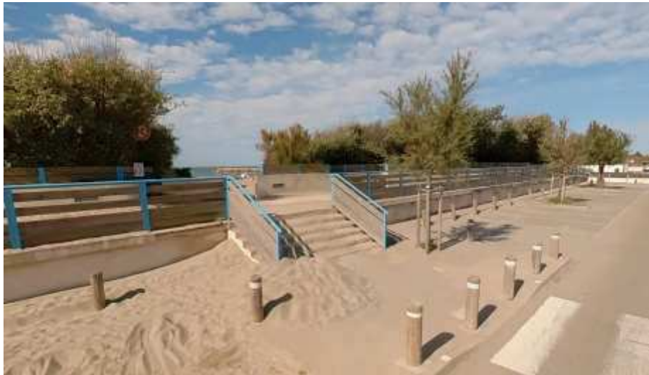
Photo 4. Secteur Av . Aubanel
