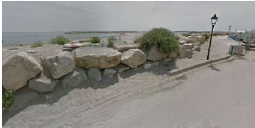
Photo 12. Vue du raccordement avec le parking de la plage Est
