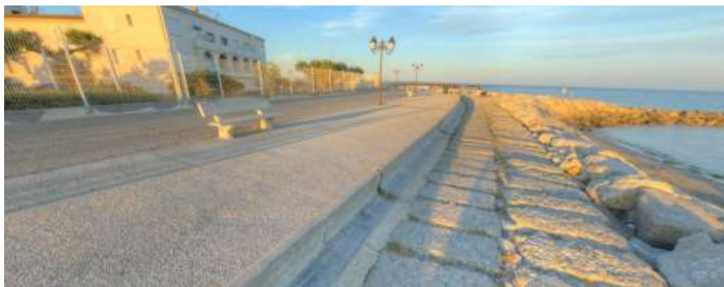
Photo 8. Protection, juste en aval des arènes
