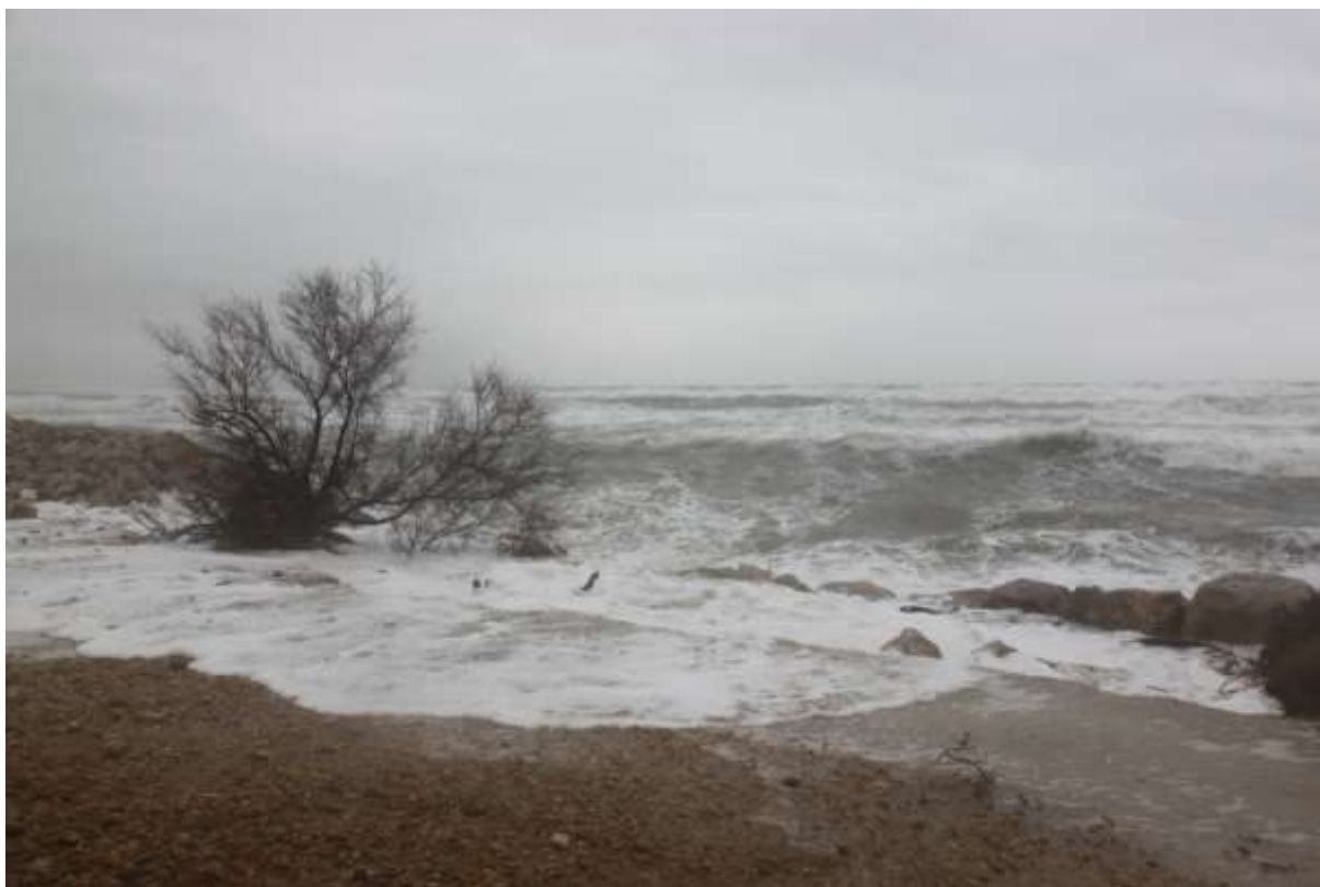
Figure 18. Départ de brèche par glissement du talus amont
