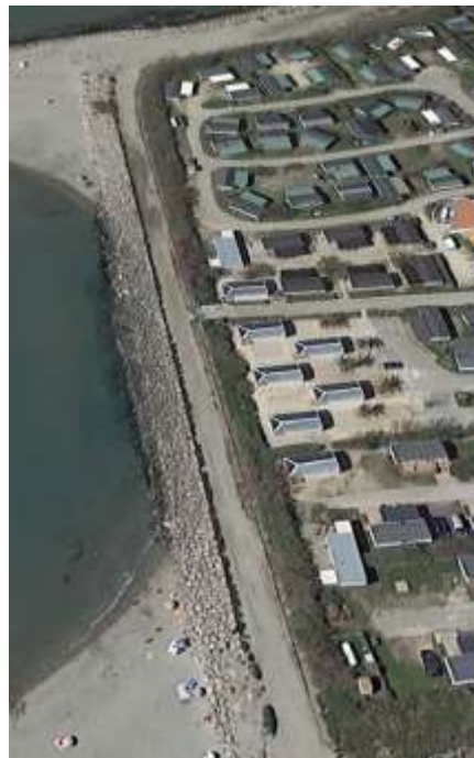
Photo 1. Vue de l'extrémité ouest de la protection
