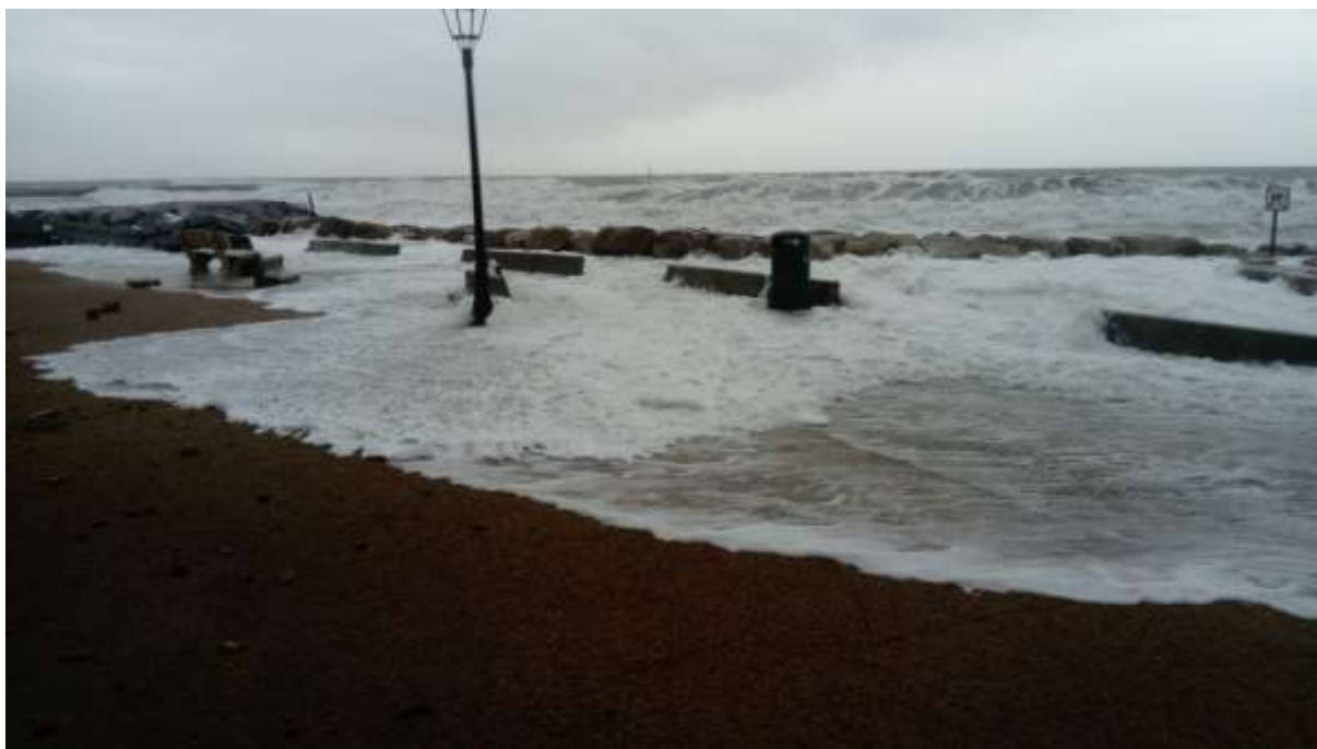
Figure 22. Entrées d'eau principalement limitées à l'ouvrage de protection (flux et reflux)
