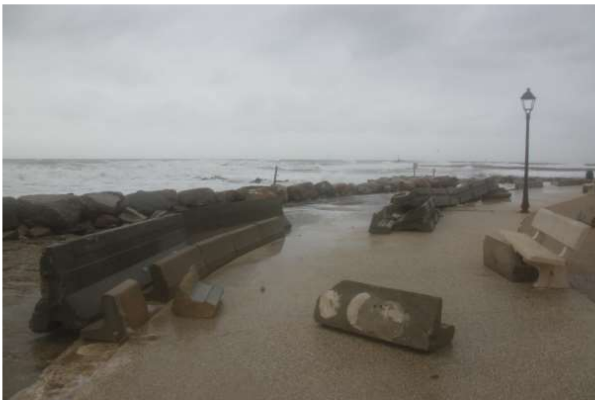
Figure 23. GBA et mur chasse mer partiellement renversés
