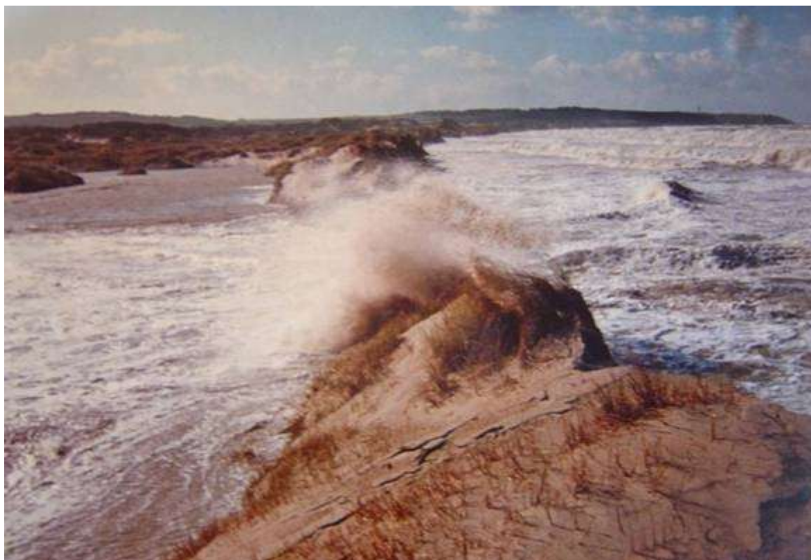
Figure 3. Brèche dans une digue à Wissant (Source : DREAL Haut de France)
