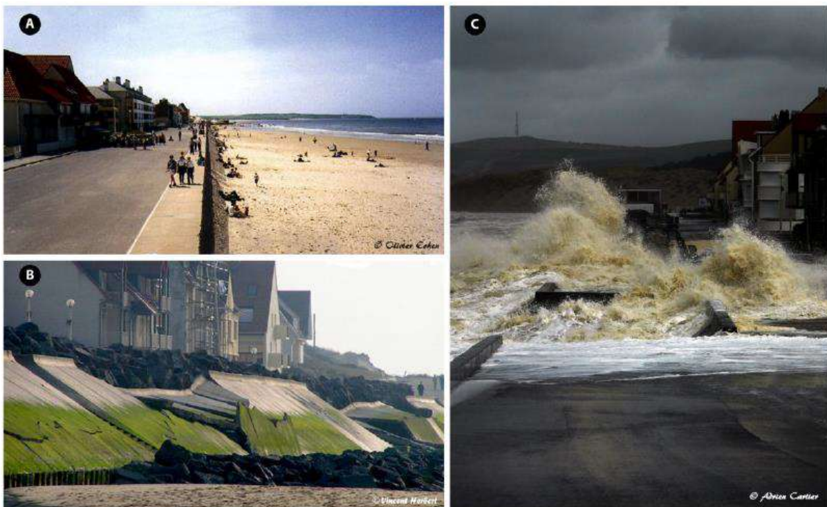
Figure 7. La digue de Wissant en 1998 (A) et en 2007 (B) : Le niveau de sable s'est abaissé d'environ 8m ; (C) submersion de la digue lors de la tempête de mars 2010
