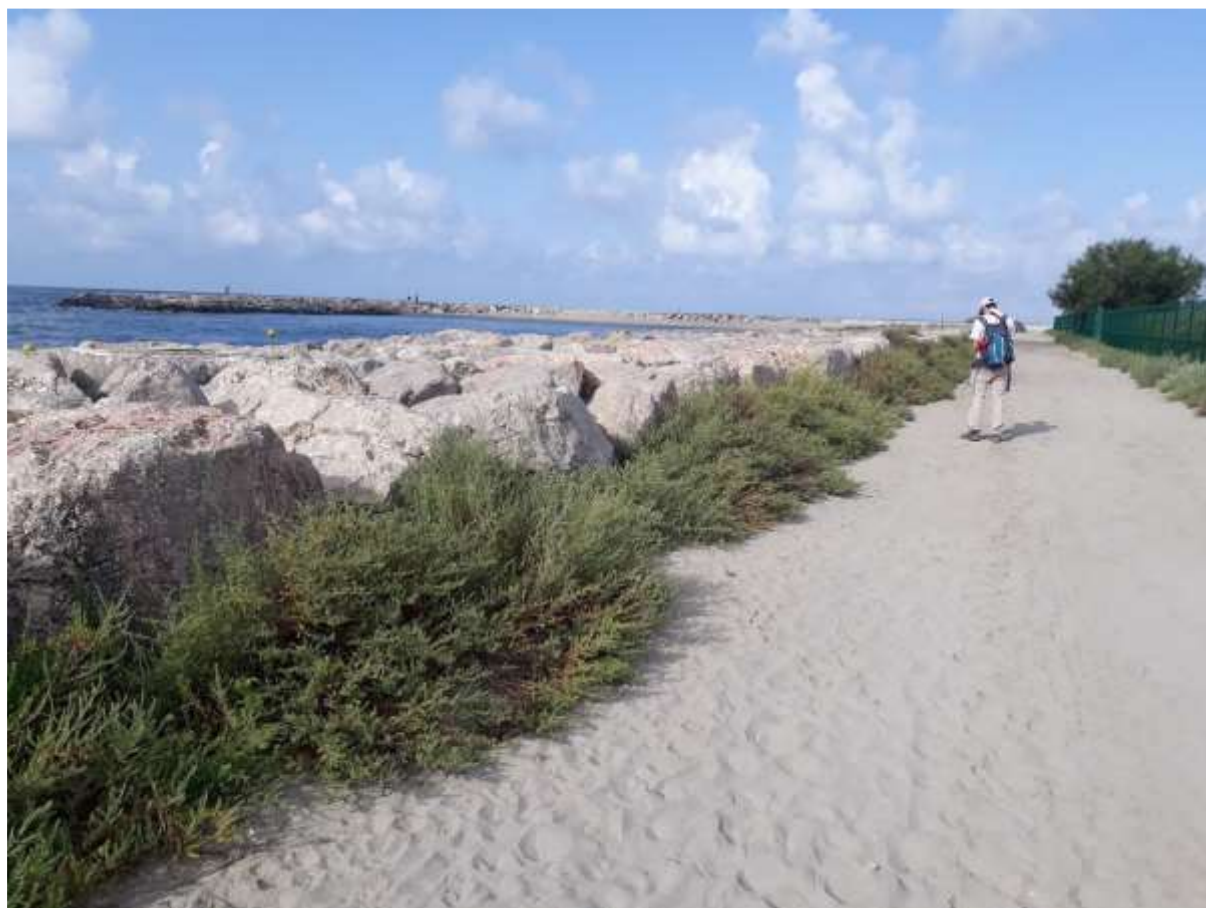
Photo 2. Secteur du Clos du Rhône : enrochements entre 2.4 et 2.7 ; piste entre 1.4 et 1.6 mNGF
