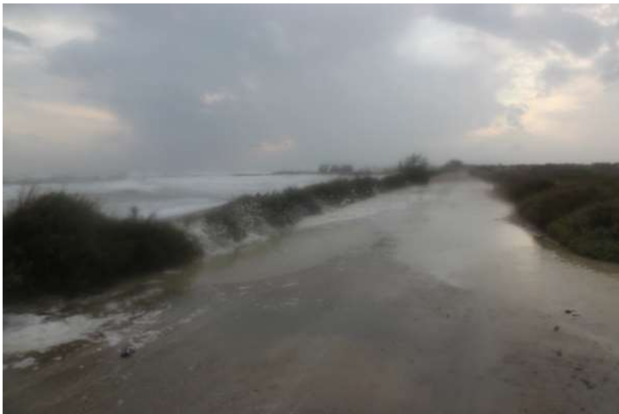
Figure 14. Déferlements sur la digue à la mer
