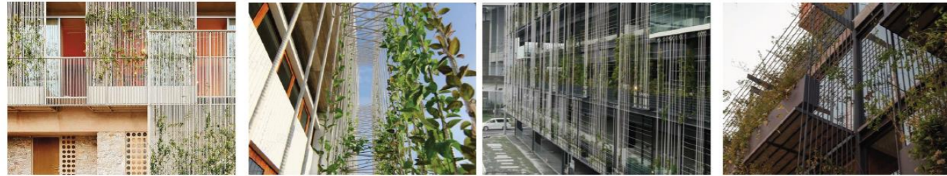
Système de structure métallique verticale avec jardinière pour plantes grimpantes
