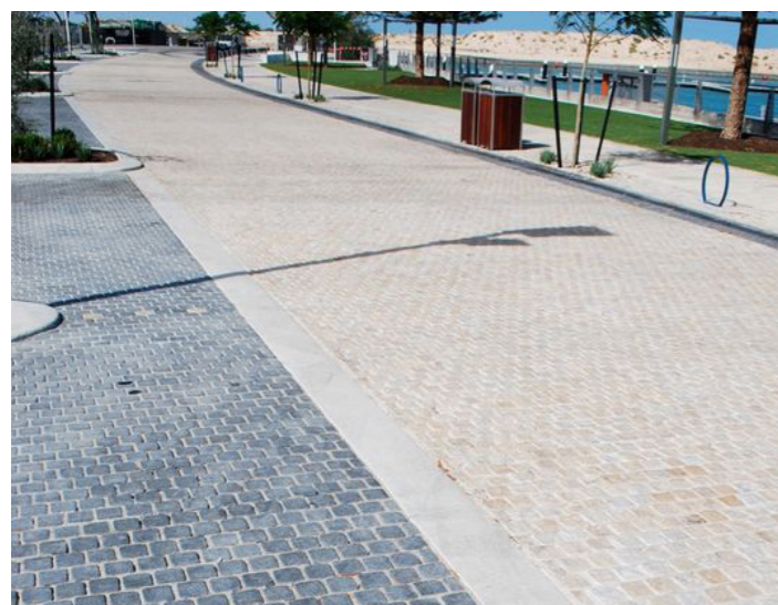
revetement de sol en pavé calcaire
