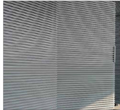
Portes garages et grilles ventilation en ventelles filantestype DUCOWALL Coloris dito menuiseries
