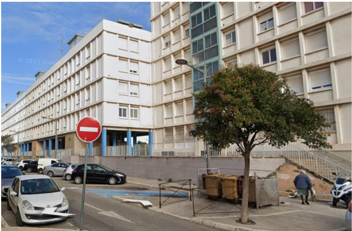
Photo 4 : Vue proche 4 depuis la rue du Môle (Google Street)
