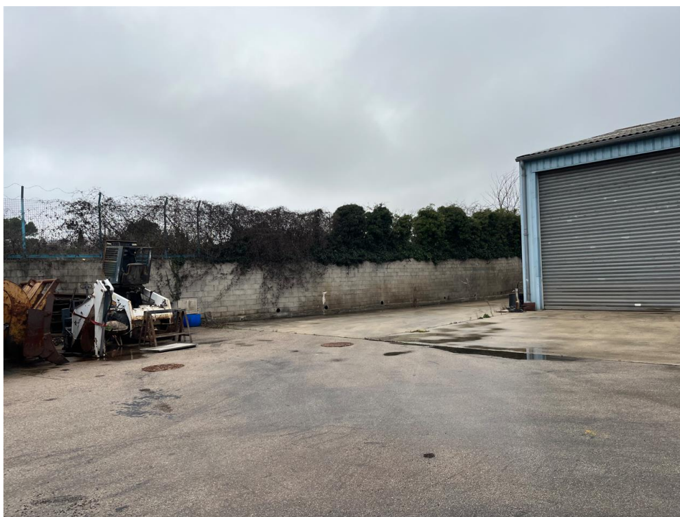
Figure 14 : Mur de soutènement érigé tout autour de la parcelle
