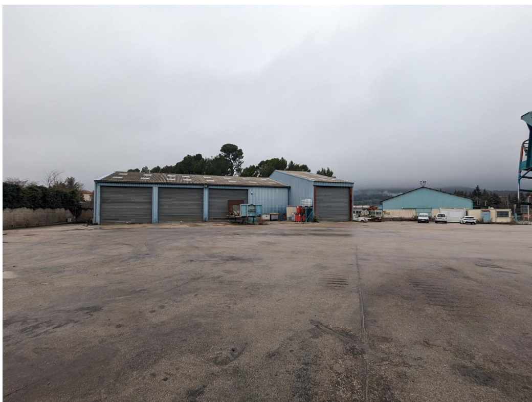
Figure 10 : Occupation actuelle du terrain (prise de vue depuis l'extrémité Sud)
