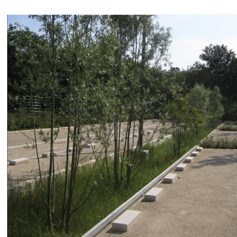
Noue plantée, sol imperméable, butte route béton
