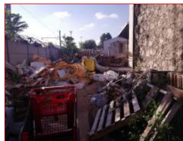
Figure 74 : Un site laissé à l'abandon (EODD 09/2021)
