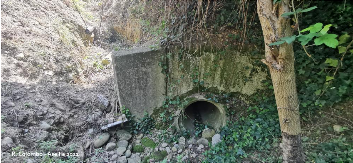
Buse passant sous la route située à l'Ouest de la zone d'étude ©R.COLOMBO
