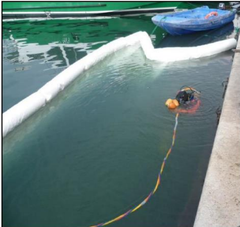
Figure 14. Utilisation d'un filet anti-MES similaire lors des travaux de réhabilitation des quais du port de St-Tropez ICTP 2011
