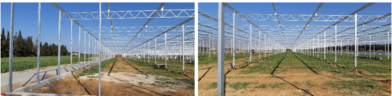
Figure 23 - Montage structure d’une serre agrivoltaïque. Reden.
