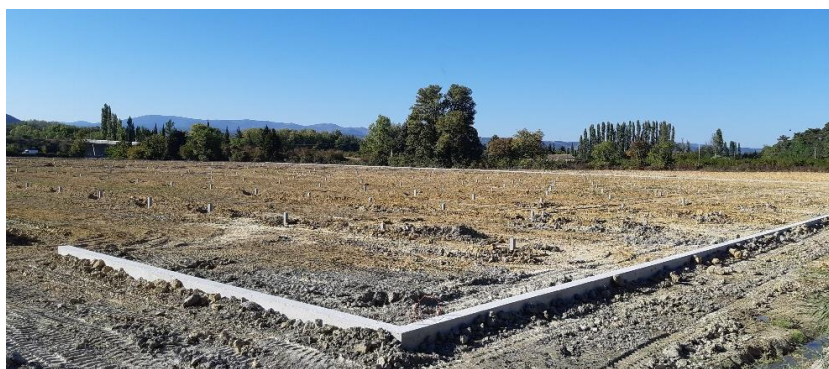
Figure 25 - Fondations béton extérieures (longrine). Reden.
