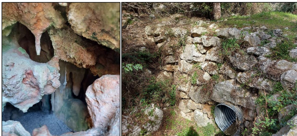
Figure 15 : Exemples de cavités représentant des gîtes potentiels – Gauche : cavité sur le mur rocheux – Droite : Mur en pierres sèches du vallon sec
