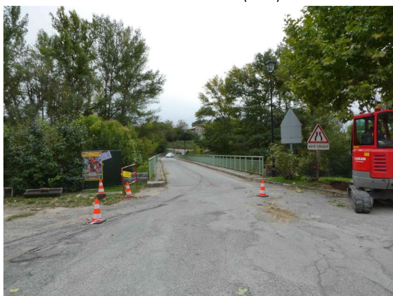
Photo 7 – Dessus d'ouvrage depuis la berge droite (2023)
