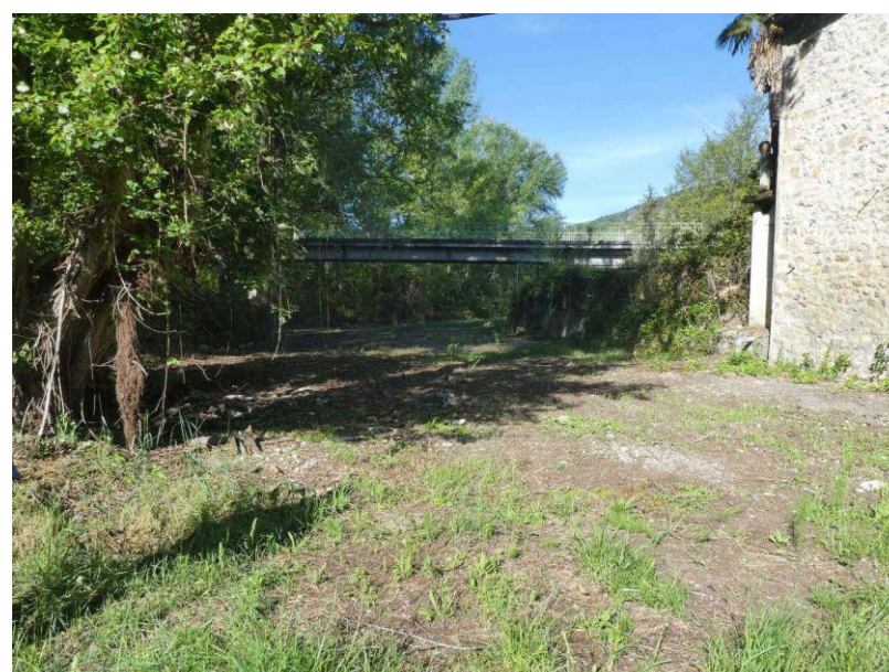
Photo 8 – Vue amont de l'ouvrage – travée droite (2023)
