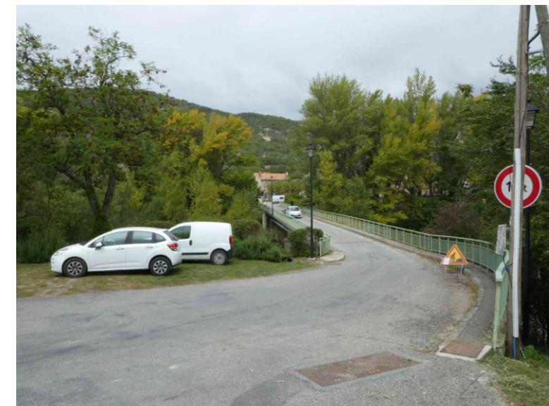
Photo 3 – Dessus d'ouvrage depuis la berge gauche (2023)
