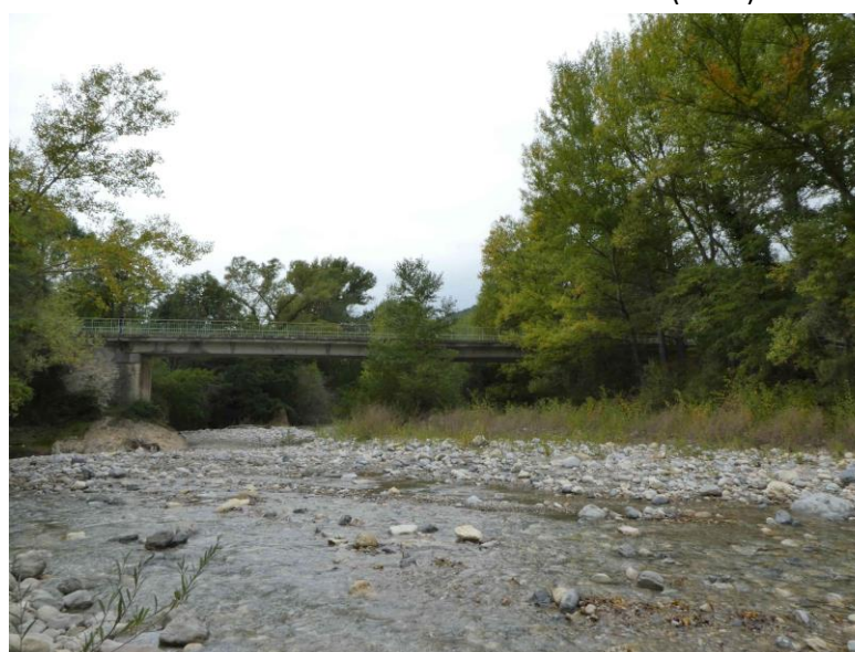
Photo 5 – Vue amont de l'ouvrage – Travées gauche et centrale (2023)
