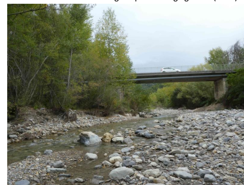
Photo 6 – Vue aval de l'ouvrage – Travée gauche (2023)
