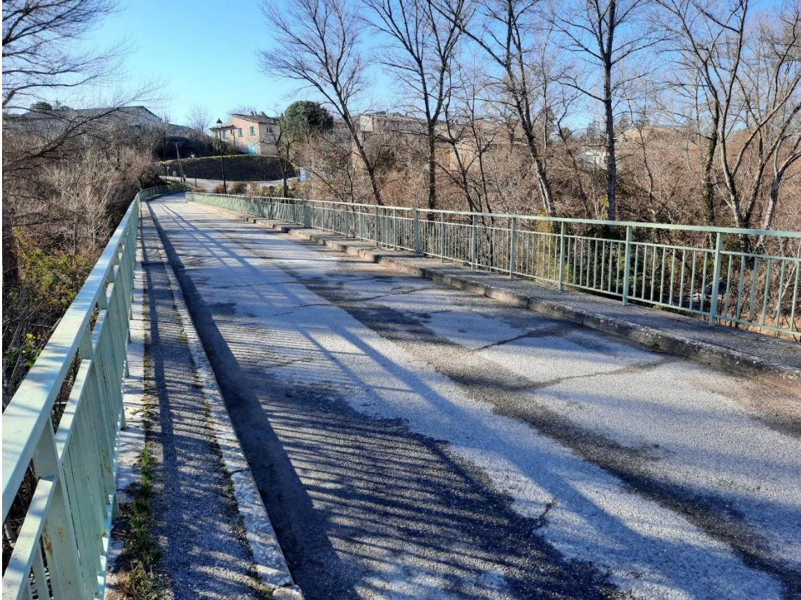
Figure 3 : Pont de SOURRIBES – PK descendant (ERG,2022)
