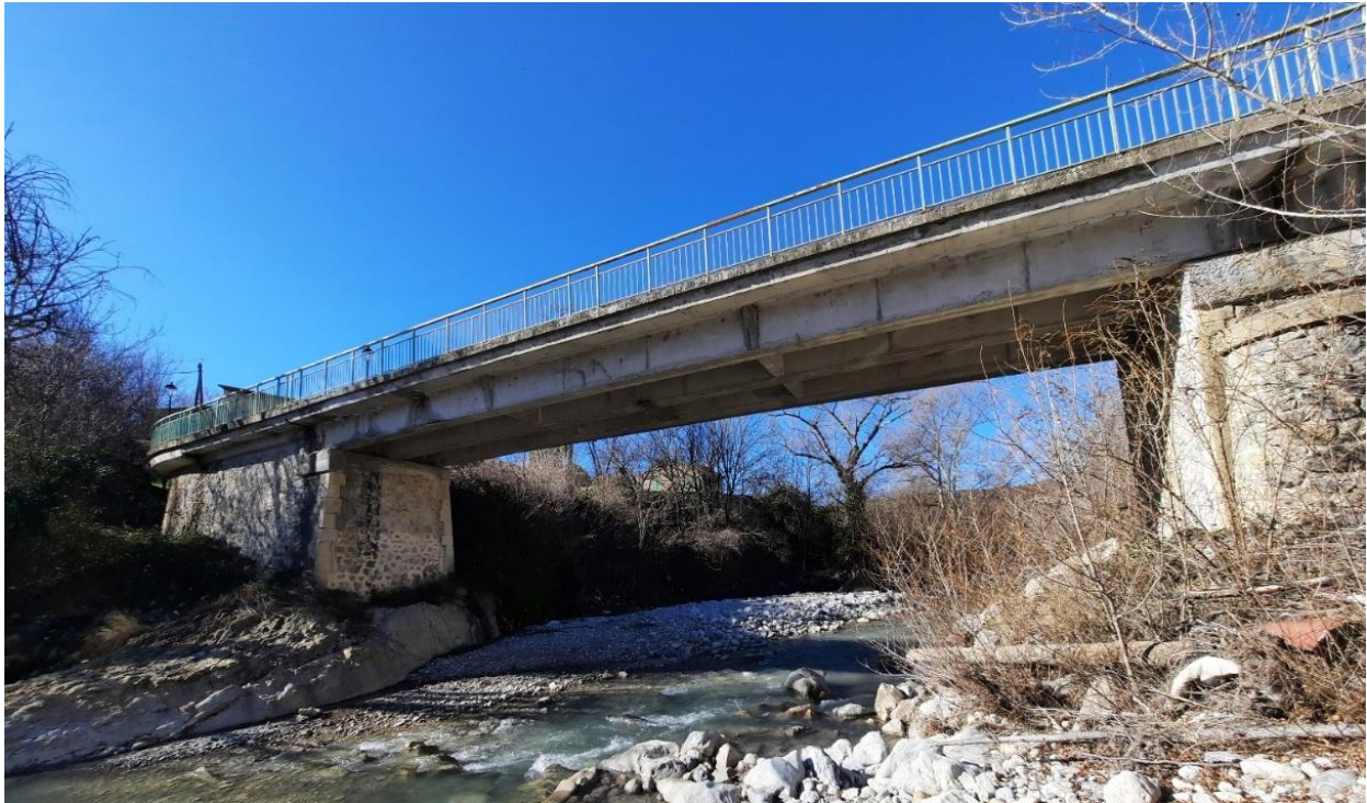
Figure 5 : Amont Pont de SOURRIBES – rive droite (ERG,2022)
