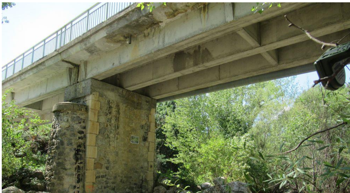
Figure 16. Illustration du tablier du pont de Sourribes, dépourvu d'éléments favorables à l'accueil en gîte de chiroptères
