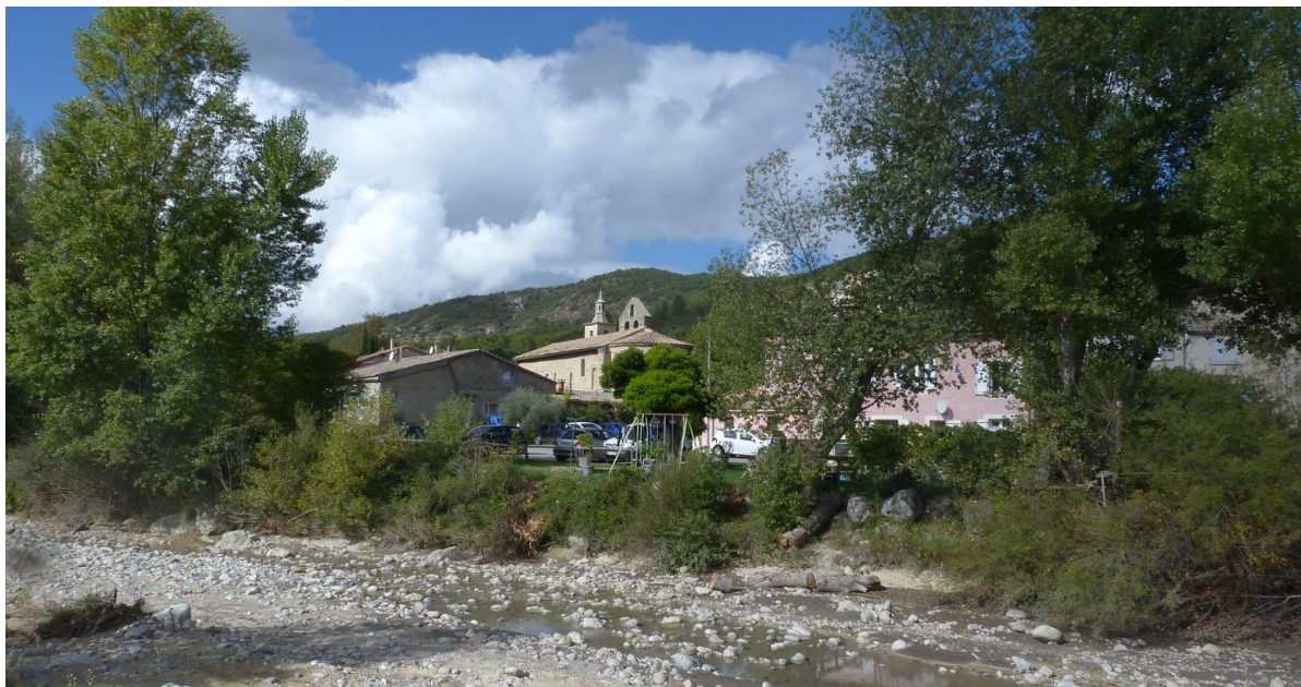
Rive droite : enrochements, roncier et cordon de ripisylve devant le village de Sourribes
