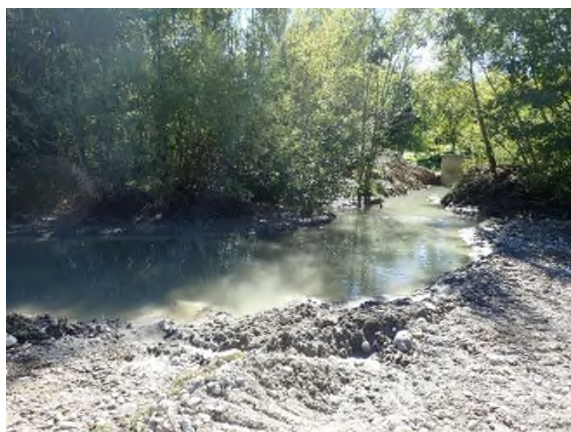
Photo 1 : Creusement d'un chenal vers le champ captant (4 octobre 2022)
