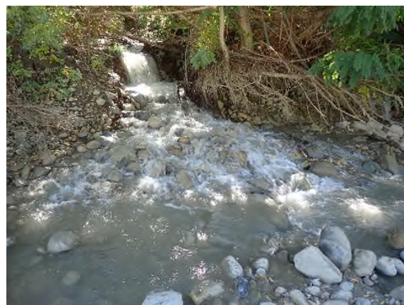
Photo 2 : Retour d'eau en amont du pont
