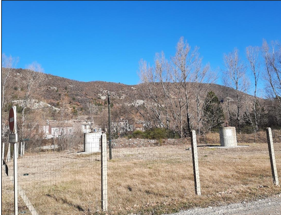
Figure 14 Deux forages d'eau – ERG 2022
